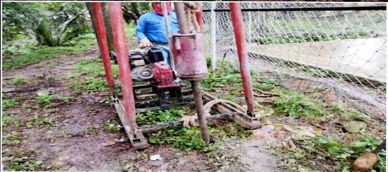
FOTOS No. 1 y 2. UBICACIÓN, AVANCE Y TOMA DE MUESTRAS SONDEO 1
