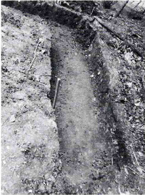
2.1 Excavación en material común
