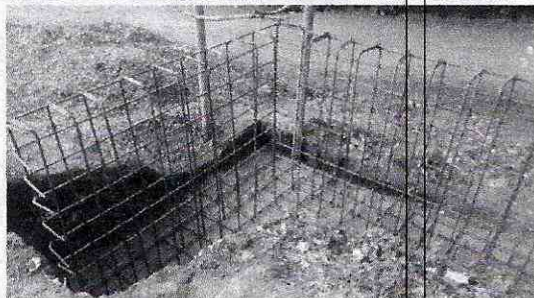
4.1 Acero de Refuerzo
