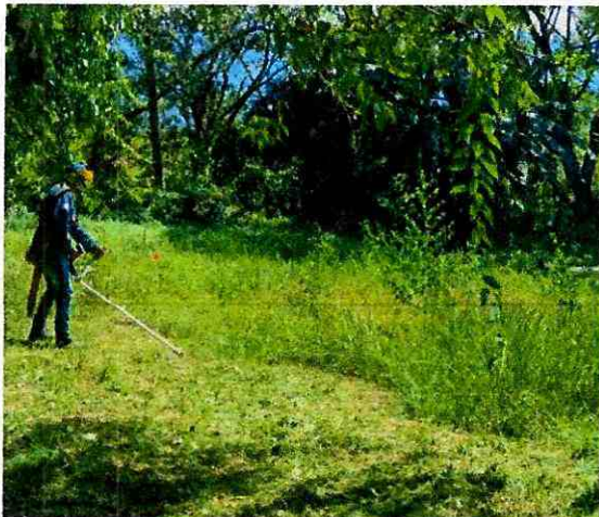
Foto 223. Labores de limpia general
