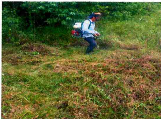
Foto 169. Limpia del terreno
