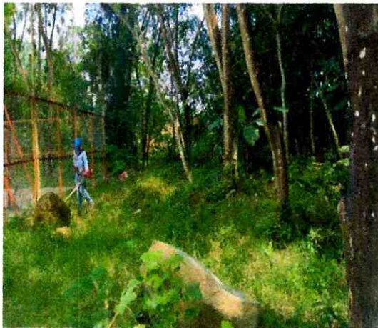
Foto 181. Limpia general del terreno
