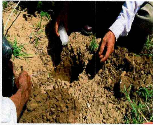
Foto 38. Aplicación de hidrotenerdor al hoyo
