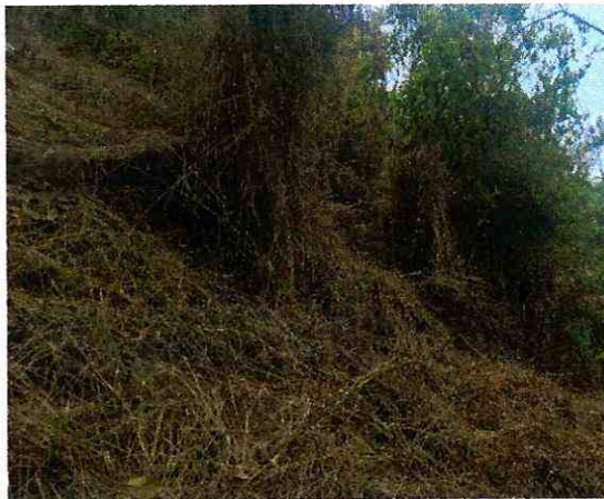
Foto 45. Labores de limpia con guadaña
