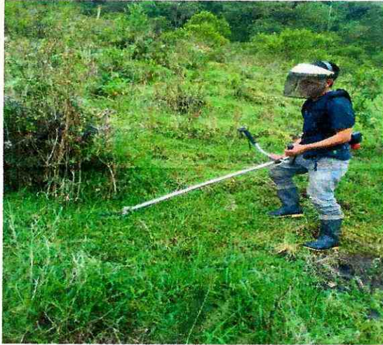
Foto 5. Limpia general del terreno
