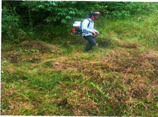
Foto 101. Limpia del terreno
