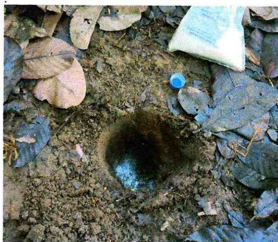
Foto 93. Ahoyado y preparación del hoyo
