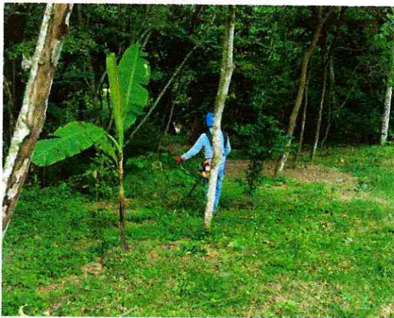
Foto 119. Limpia general del terreno
