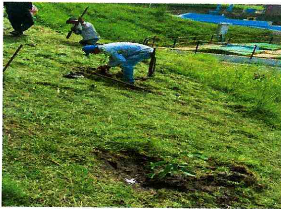
Foto 131. Plateo y limpia del terreno
