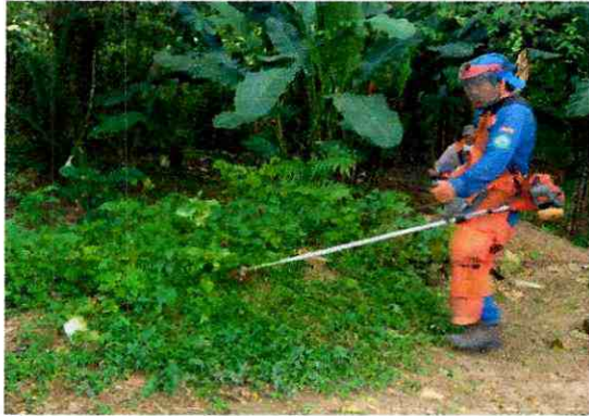
Foto 315. Limpia del terreno con guadaña
