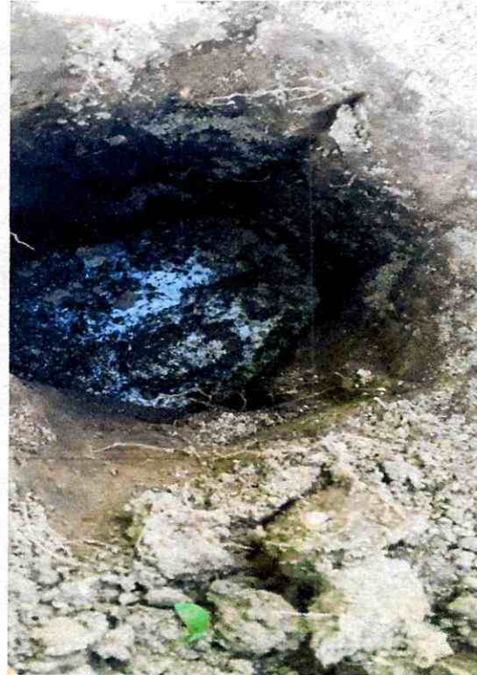
Foto 387. Adecuación de hoyo (hidroretenedor)
