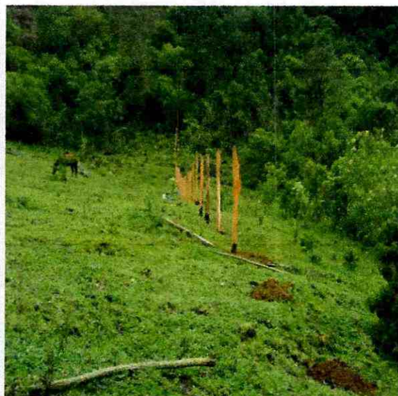
Foto 349. Hincado de postes
