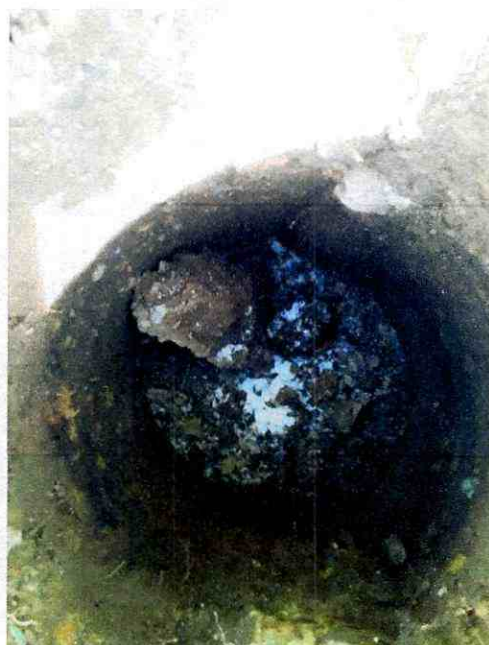
Foto 408. Adecuación del hoyo
