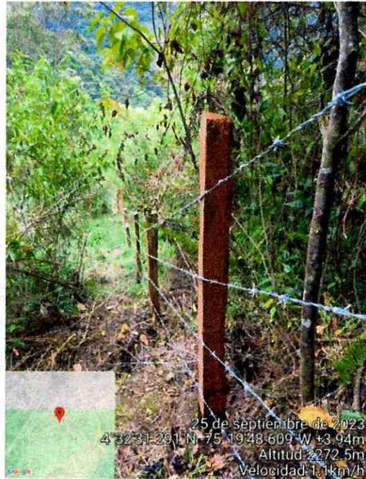
Foto 359. Cerco protector en madera
