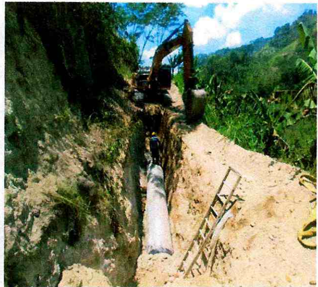
EXCAVACION PARA INSTALACION TUBERIA WSP 36"
