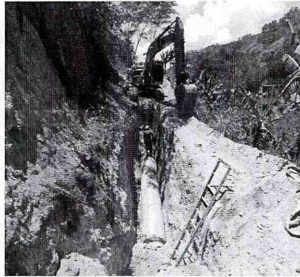
EXCAVACION PARA INSTALACION TUBERIA WSP 36"
