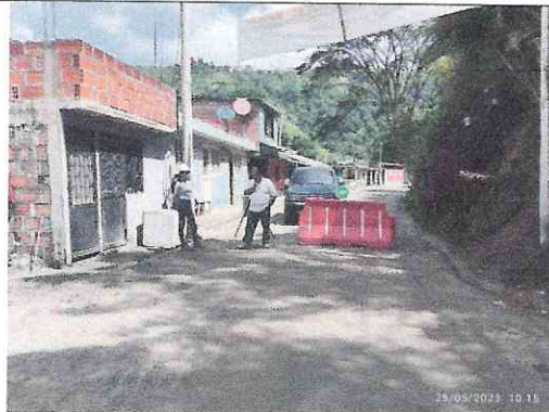
Vista de cierres temporales por ejecución de actividades sector túneles – vereda la tigrera.
