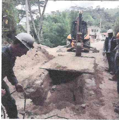
Vista de cierres temporales por ejecución de actividades sector túneles – vereda la tigrera.
