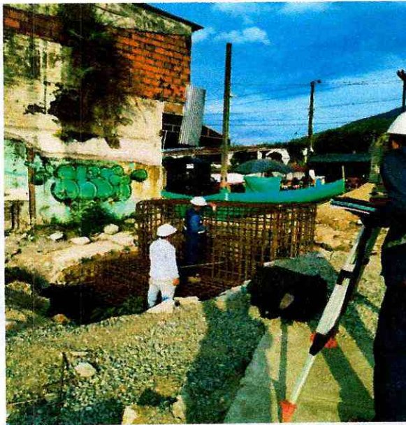
FRENTE PUENTE 12 (CIMENTACION PROFUNDA TIPO CAISSON)
