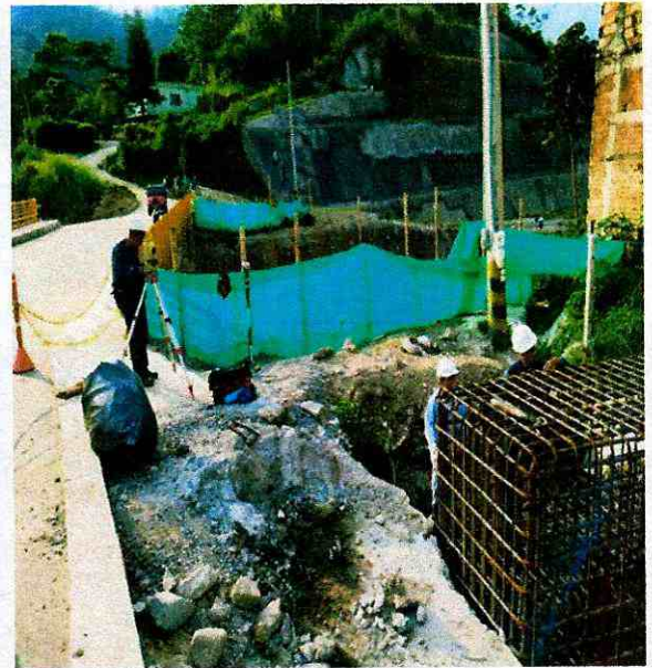
FRENTE PUENTE 12 (CIMENTACION PROFUNDA TIPO CAISSON)
