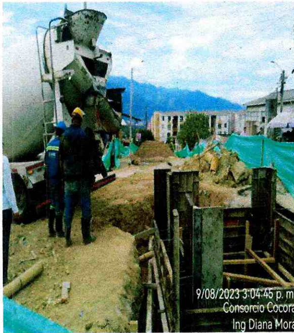
FRENTE PUENTE 12 (CIMENTACION PROFUNDA TIPO CAISSON)
