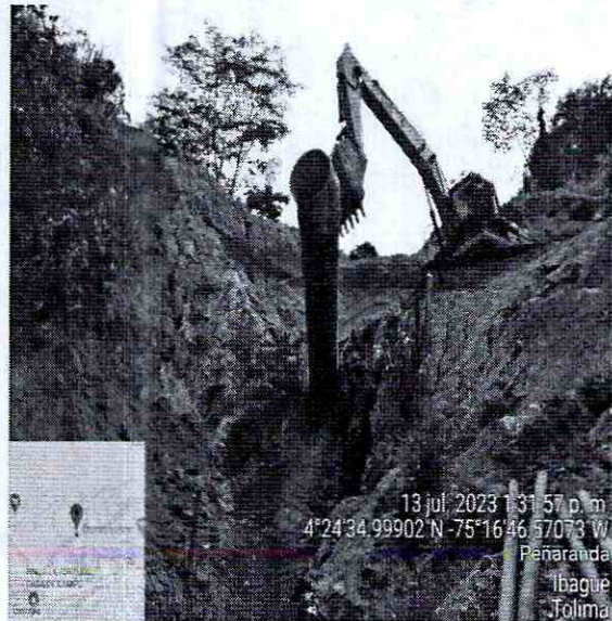
EXCAVACION E INSTALACION TUBERIA ACERO AL CARBON
