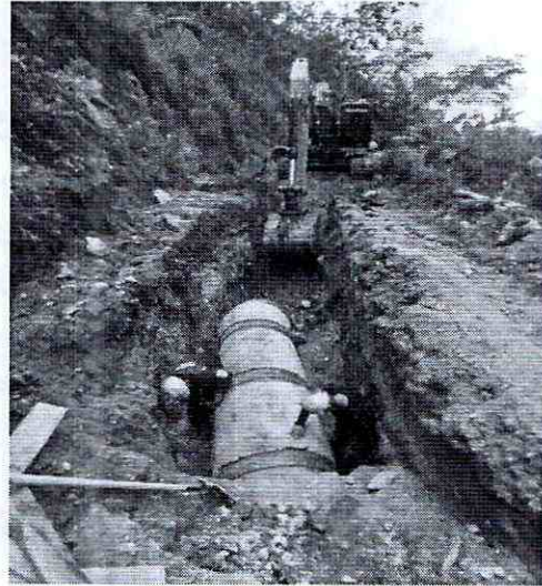
EXCAVACION E INSTALACION TUBERIA ACERO AL CARBON
