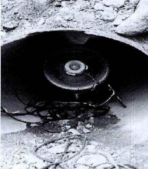
Suministro de aire
