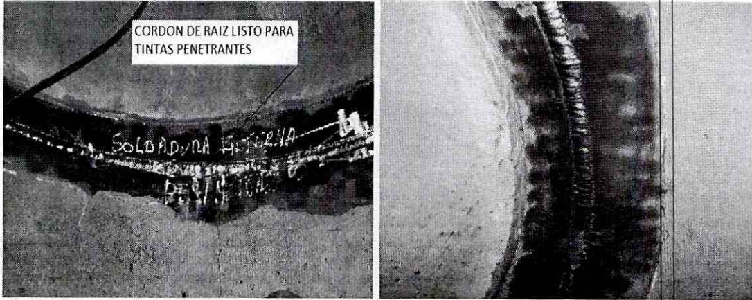
LIMPIEZA DE SOLDADURA PARA APLICAR TINTAS
