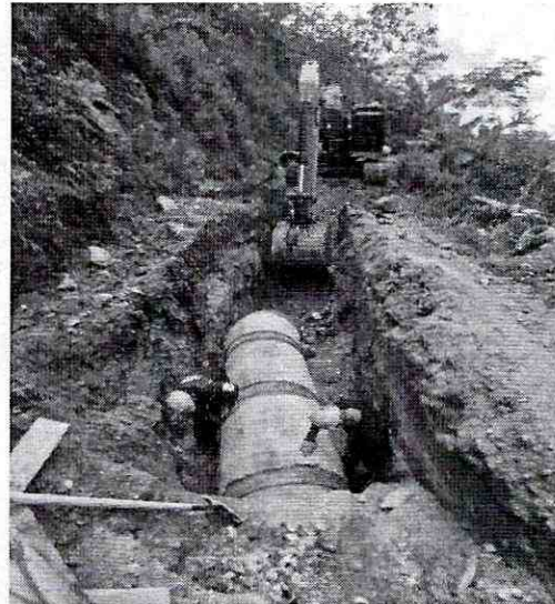
EXCAVACION E INSTALACION TUBERIA ACERO AL CARBON
