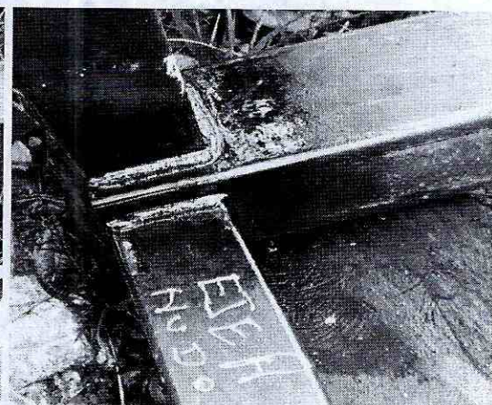
APLICACION DEL PENETRANTE
