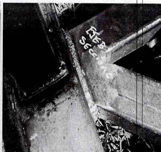
APLICACIÓN DEL PENETRANTE
