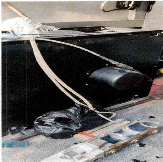
Figura NO.3 mantenimiento transportador pipe ranger
