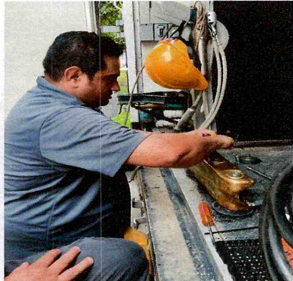
Figura NO.4 Instalación de filtro
