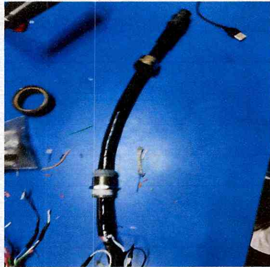
Figura NO.6 reparación cable multi-conductor
