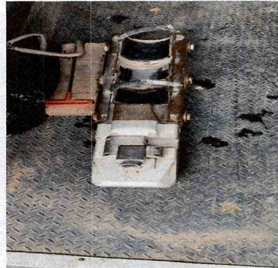
Figura NO.4 mantenimiento transportador pipe ranger
