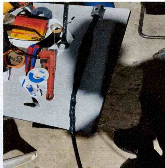
Figura NO.8 reparación cable multi-conductor
