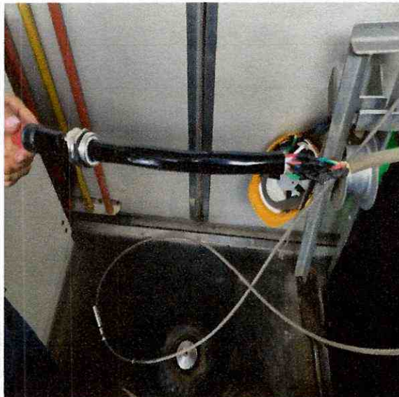
Figura NO.5 Instalación de conector
