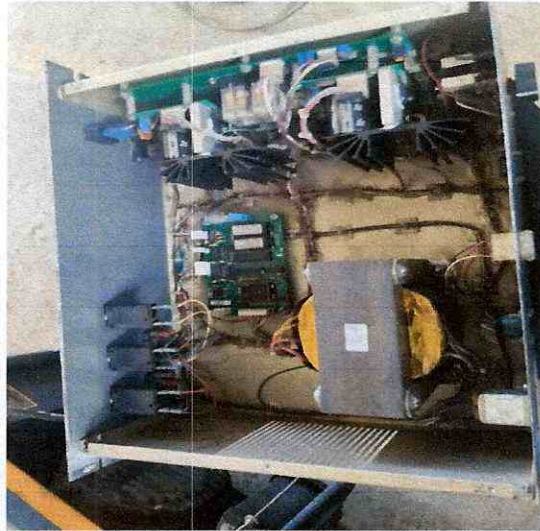
Figura NO.22 instalación labor electrónica
