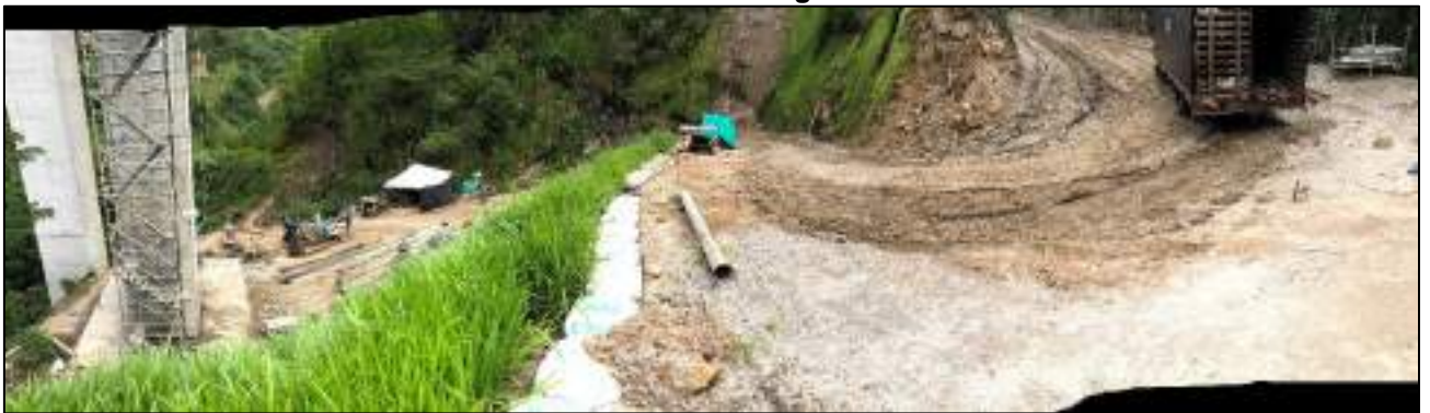
Ilustración 8-26 Puentes 17 – Vista general No.2
