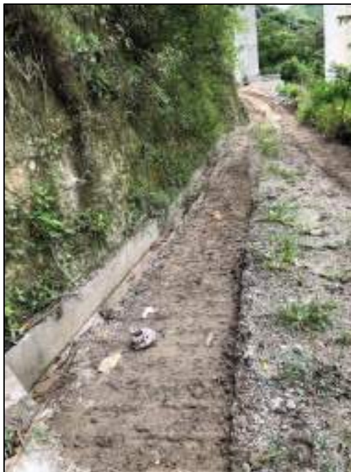
Ilustración 8-28 Puesto 17 – vía terciaría a intervenir
