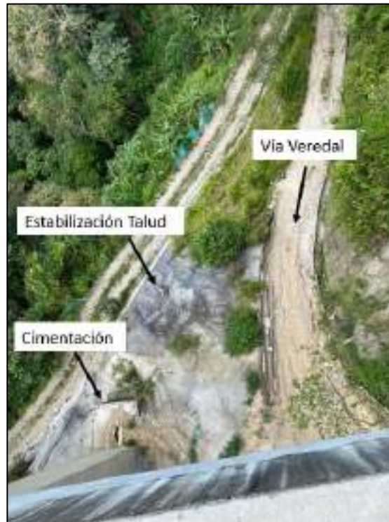
Ilustración 8-36 Estabilización de talud cerca a la cimentación de puente 17
