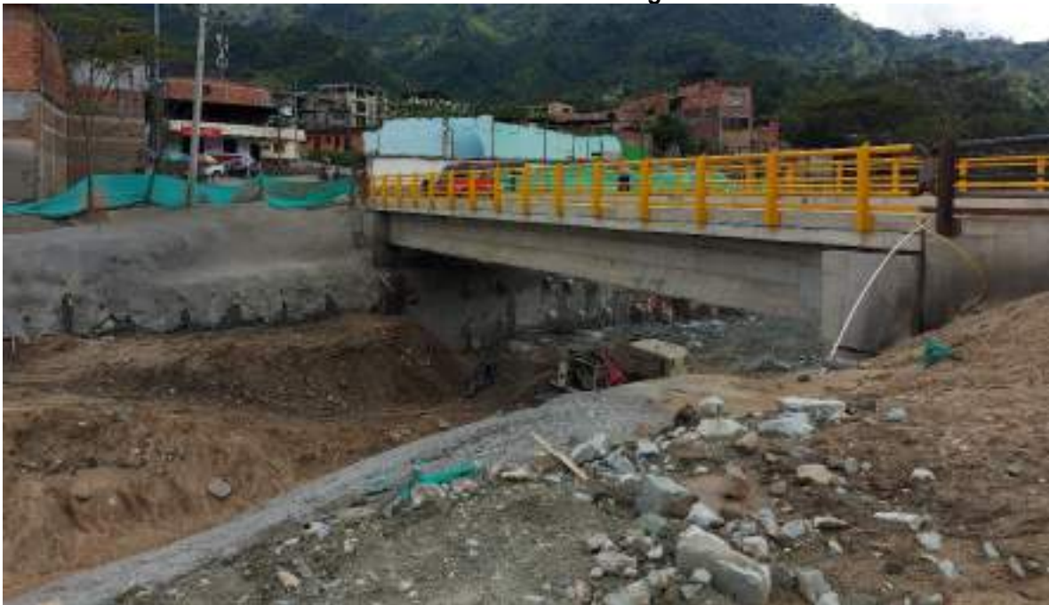
Ilustración 8-70 Puente 12 – Vista general No.2
