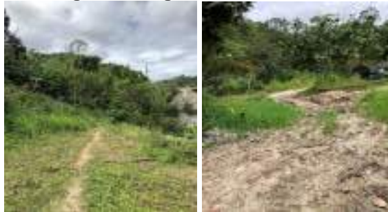
Ilustración 5-3 Registro fotográfico, Tramo K8+990 a K9+880
