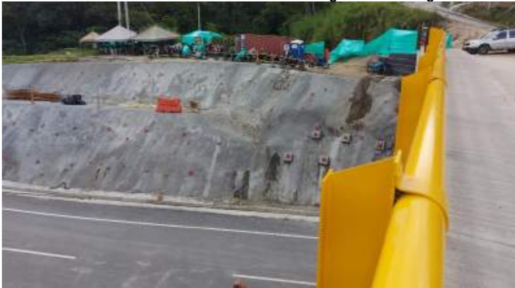
Ilustración 8-72 Puente 12 – Obras estabilización aguas arriba margen derecho
