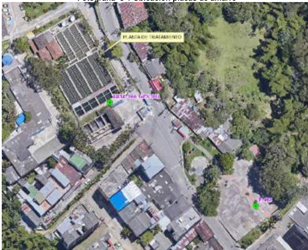
Fotografía 8-1 Ubicación placas de amarre
