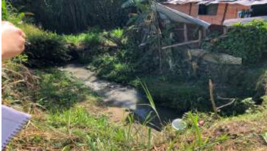
Ilustración 8-127 Vista general tramo aguas arriba del box culvert
