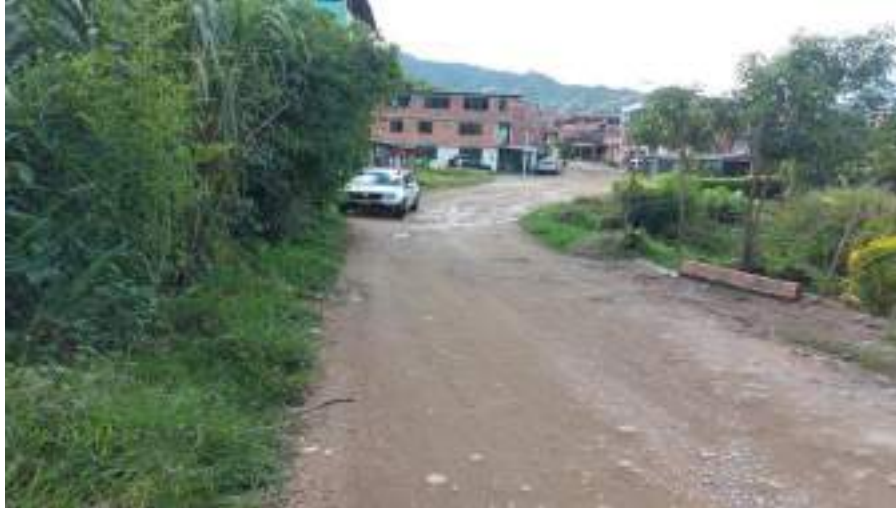
Ilustración 8-126 Vista general tramo sentido norte
