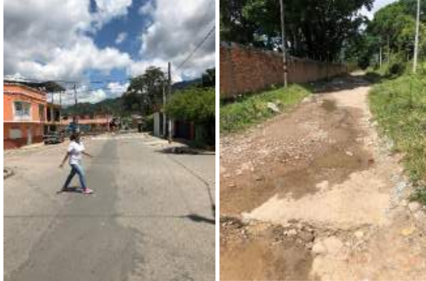
Ilustración 5-12 Registro fotográfico Tramos sin instalar distribución
