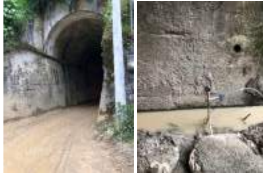
Ilustración 5-5 Registro fotográfico, Tramo K11+200 a K11+560
