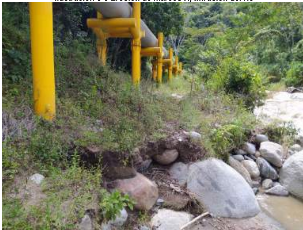
Ilustración 8-8 Erosión de marcos H, Intrusión del río
