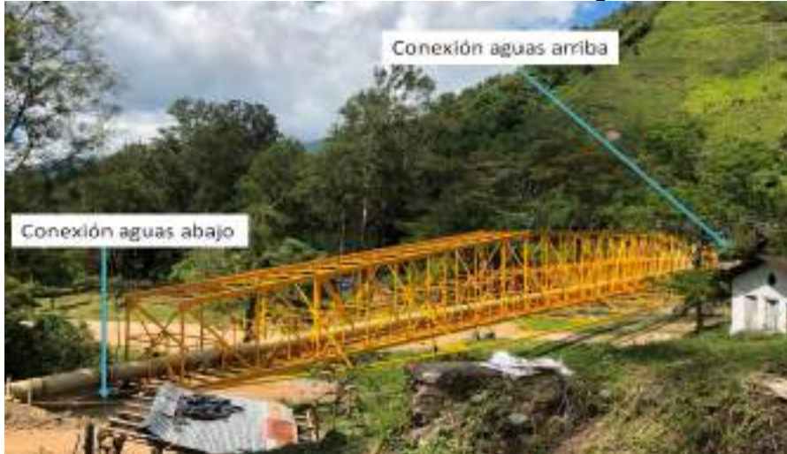
Ilustración 8-94 Tramo “Combeima” Vista general
