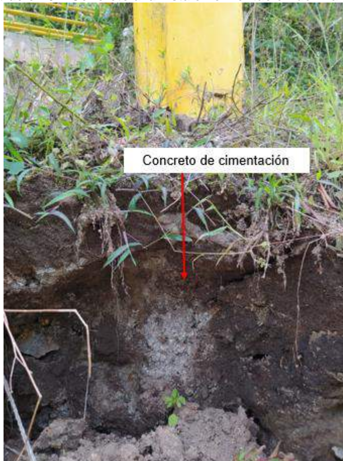
Ilustración 8-7 Concreto a la vista en cimentación del marco H
