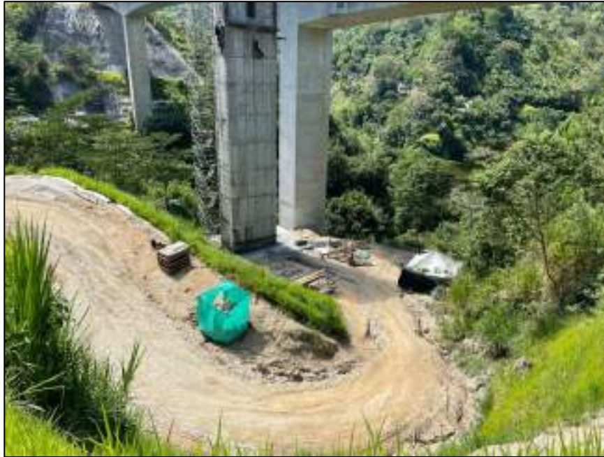
Ilustración 8-25 Puentes 17 – Vista general No.1
