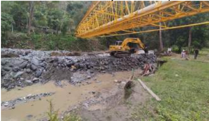
Ilustración 8-95 Obras de adecuación y estabilización de puntos críticos
