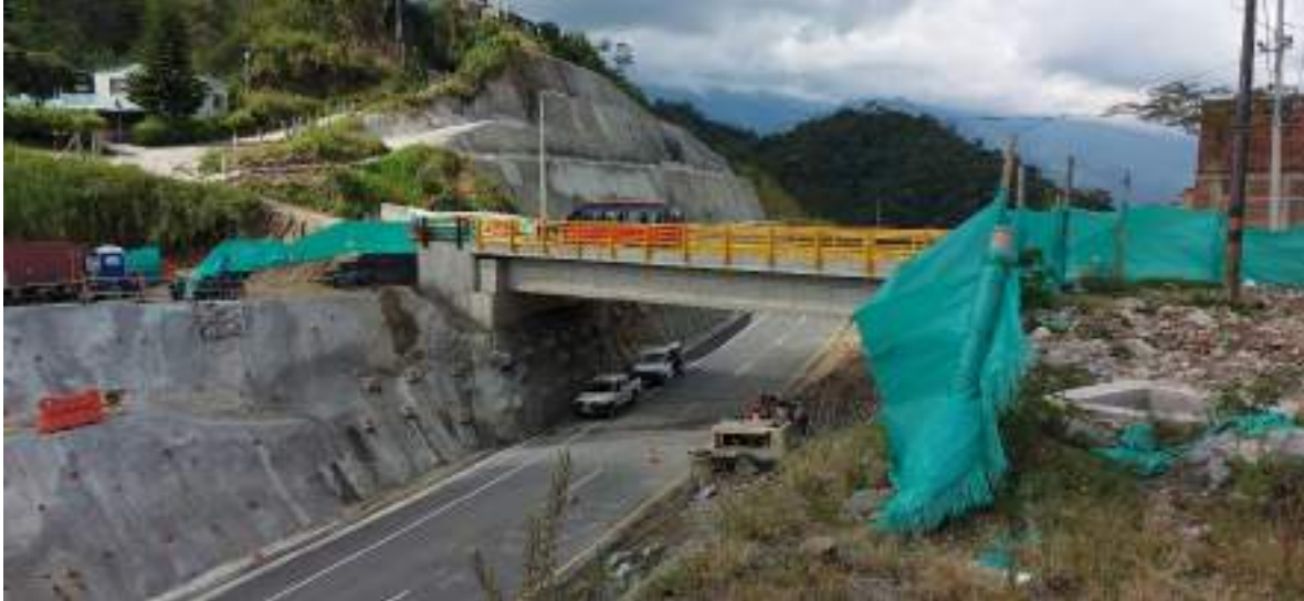
Ilustración 8-69 Puente 12 – Vista general No.1
