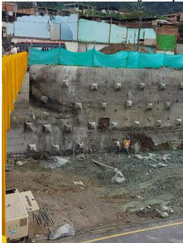
Ilustración 8-73 Puentes 12 – Obras estabilización aguas abajo margen derecho
