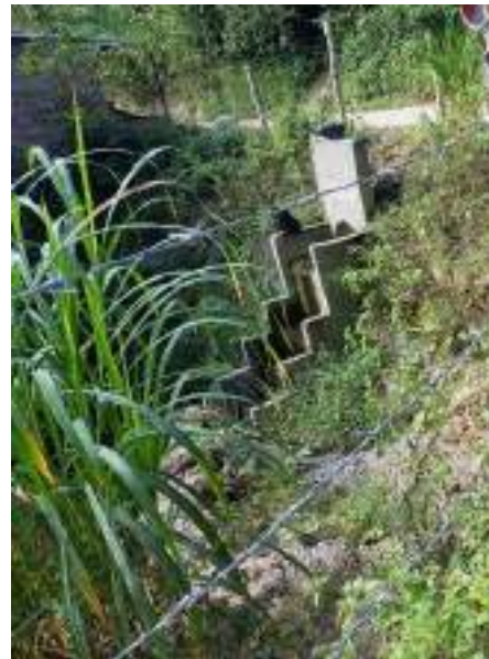
Ilustración 8-49 Reconocimiento de campo de las obras de arte – Talud, perdidas de bancada y escaleras existentes
