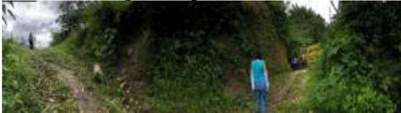
Ilustración 5-2 Registro fotográfico, Tramo K8+300 a K8+340
