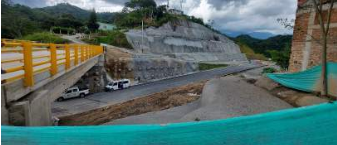
Ilustración 8-71 Puente 12 – Obras estabilización aguas arriba margen izquierdo
