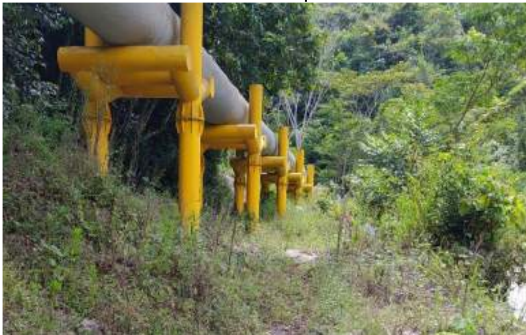
Ilustración 8-5 Marcos H soporte de tubería
