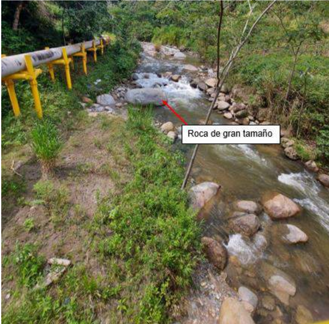
Ilustración 8-9 Vista general desde aguas abajo hacia aguas arriba
