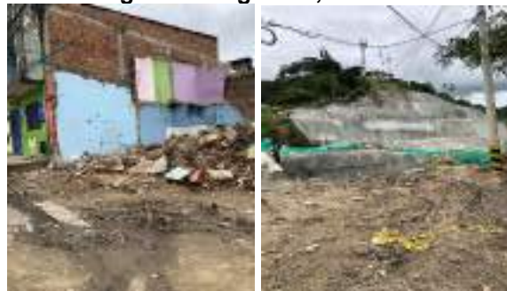
Ilustración 5-7 Registro fotográfico, Tramo K0+000 a K0+020
