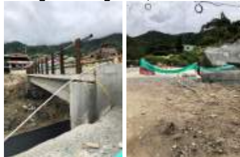
Ilustración 5-6 Registro fotográfico, Tramo K12+650 a K12+770
