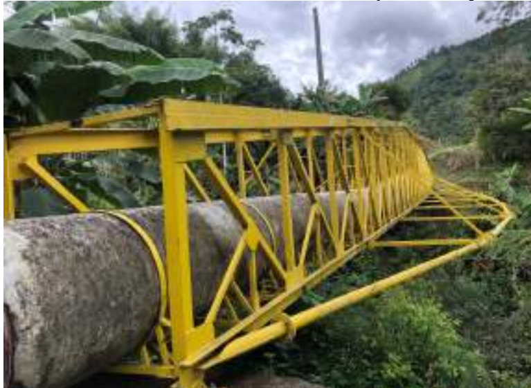
Ilustración 8-17 Viaducto 4 - Instalación de estructura tipo cercha y tubería de CCP 36"
