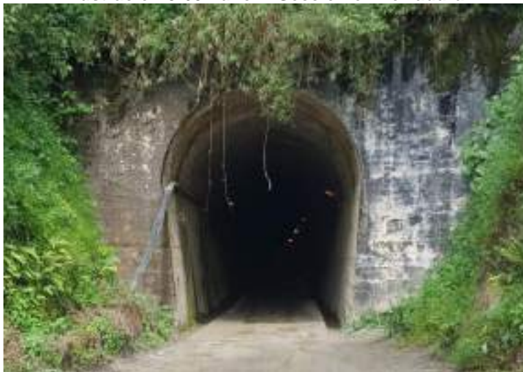
Ilustración 8-60 Túnel – Sección en herradura
