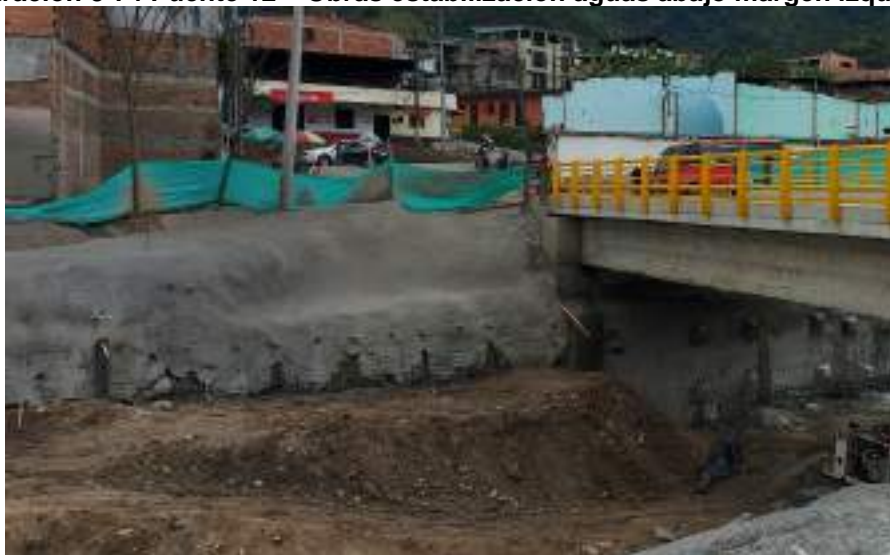
Ilustración 8-74 Puentes 12 – Obras estabilización aguas abajo margen izquierdo
