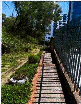
Fotografía 11.4 sendero peatonal afectado por el deslizamiento
