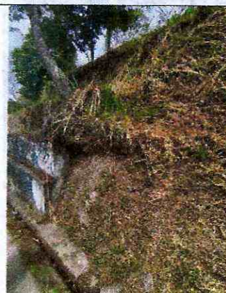
Fotografía 11.5 muro de contención con talud escarpado en la parte superior.
