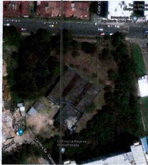
Ilustración 11-10 Predio del proyecto
