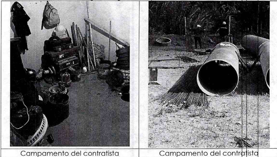
Ilustración 3: Registro fotográfico campamento de obra contratista
