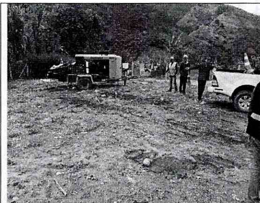
Maquinas sin contención de derrames de combustible
