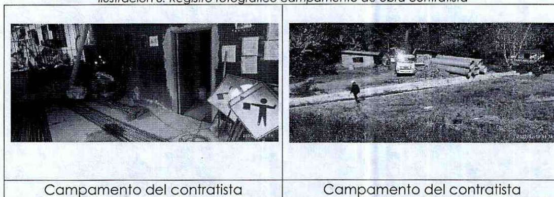
Ilustración 3: Registro fotográfico campamento de obra contratista
