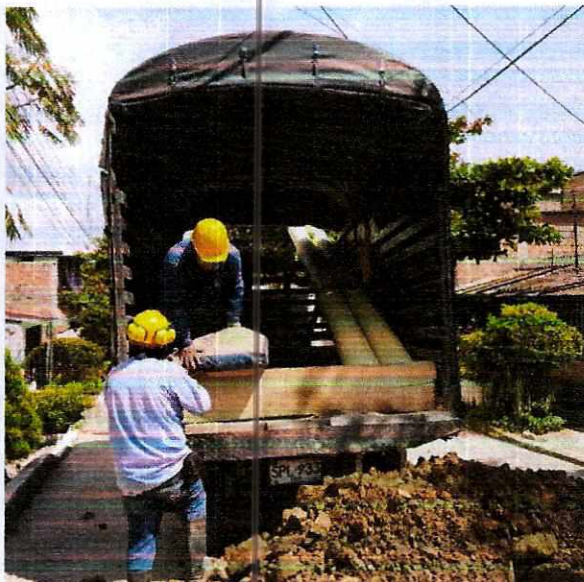
Barrio Villa del Sol
