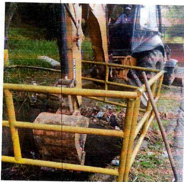
Canal Piedra Pintada Parte Baja
