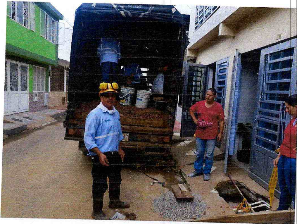
Barrio Rincón del Pedregal
