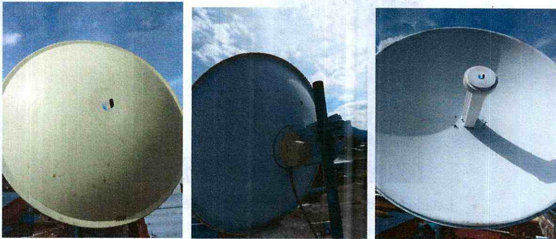
Antes de mantenimiento
