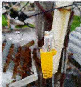
Verificación estado de Terminal rj45
