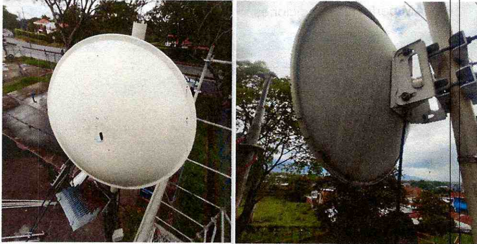
Después de mantenimiento
