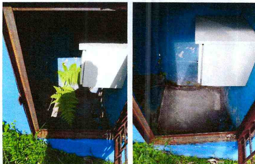
Despues de mantenimiento
