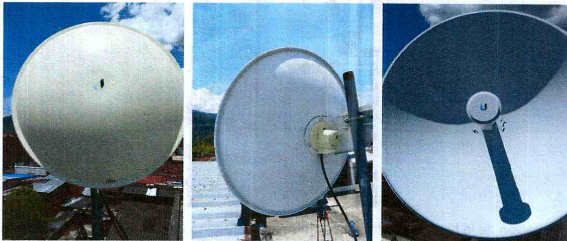
Después del mantenimiento
