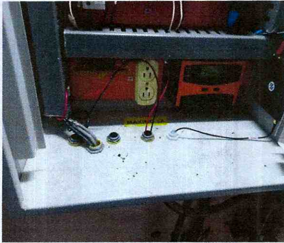
Antes de mantenimiento
