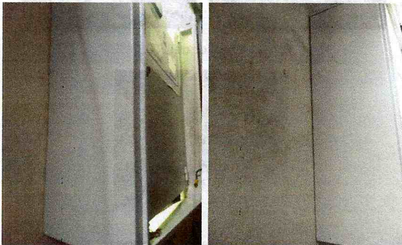
Después del mantenimiento
