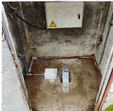
Antes de mantenimiento
