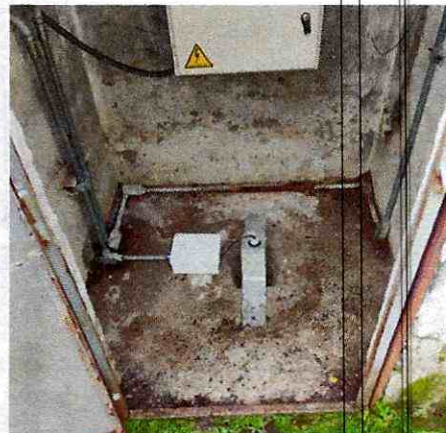
Despues de mantenimiento
