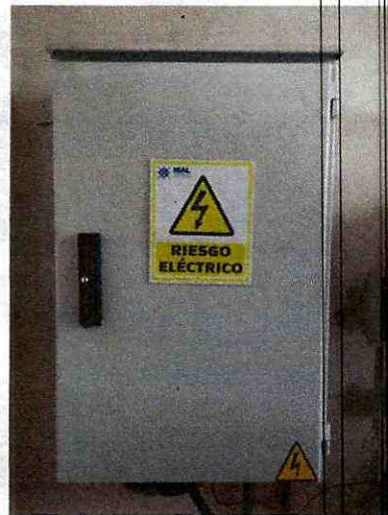
Después de mantenimiento
