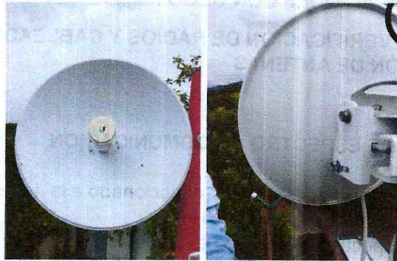
Después del mantenimiento
