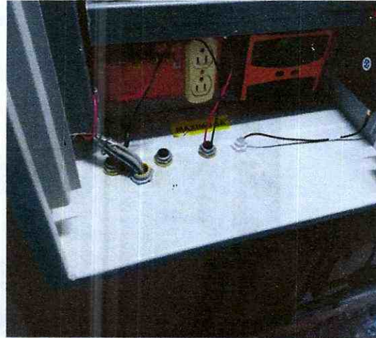
Después de mantenimiento
