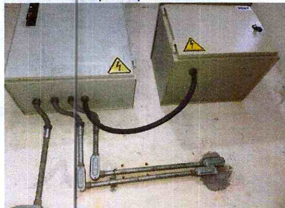
Limpieza parte inferior
