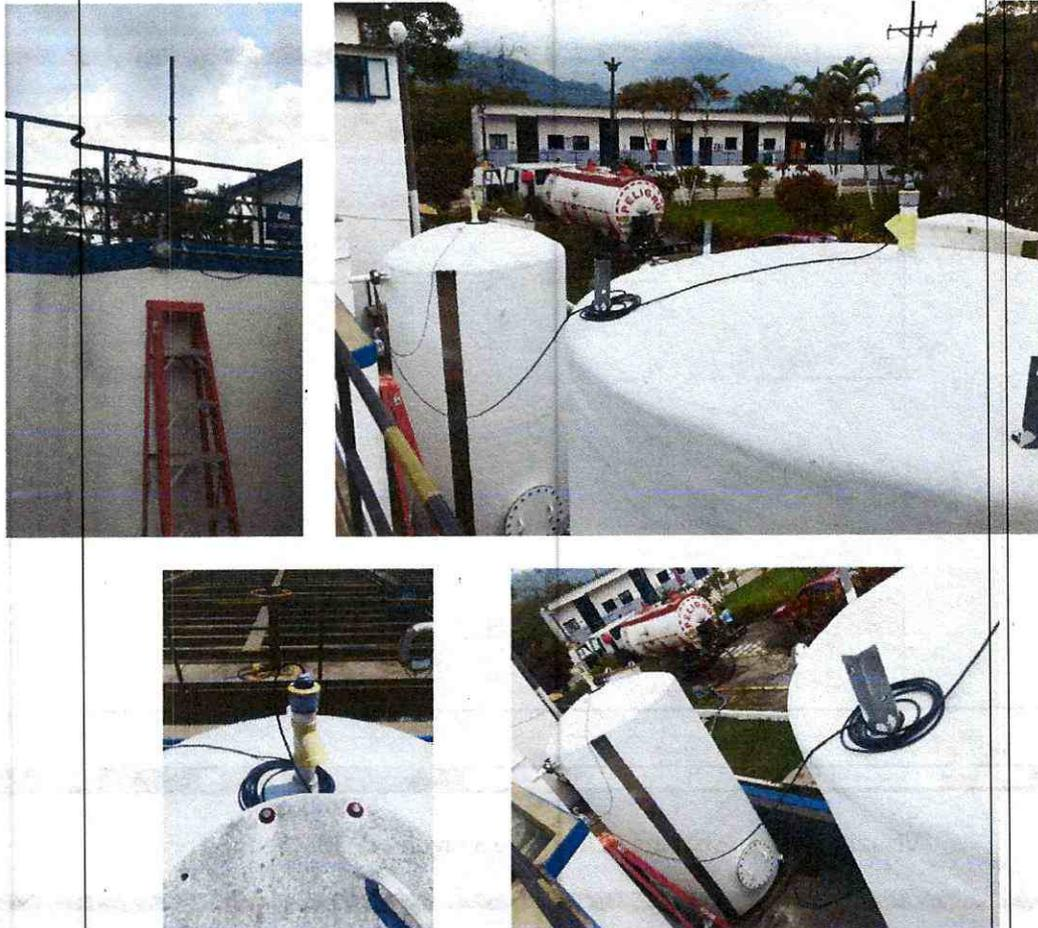
Configuración de 3 equipos vega plus c11 planta 1 por medio de app móvil
