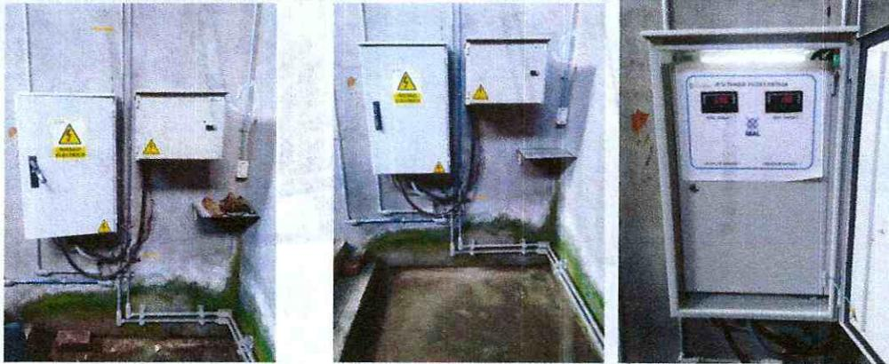
Prueba de baterías (verificación de la operación de las baterías por 6 horas mínimo). En caso de que las baterías no alcancen las 6 horas de operación estas deberán ser reemplazadas (ambas) por un juego de características iguales o mejores a las instaladas, el costo de estas no está incluido en el presente alcance.
