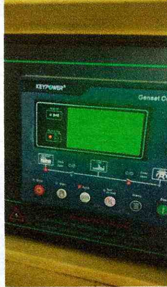
Mantenimiento planta combeima
