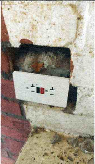
cambio de tomacorrientes GFCI en ptar Américas
