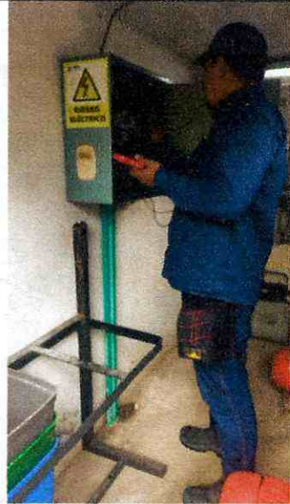
Revision de fallo eléctrico tanque de cerro gordo
