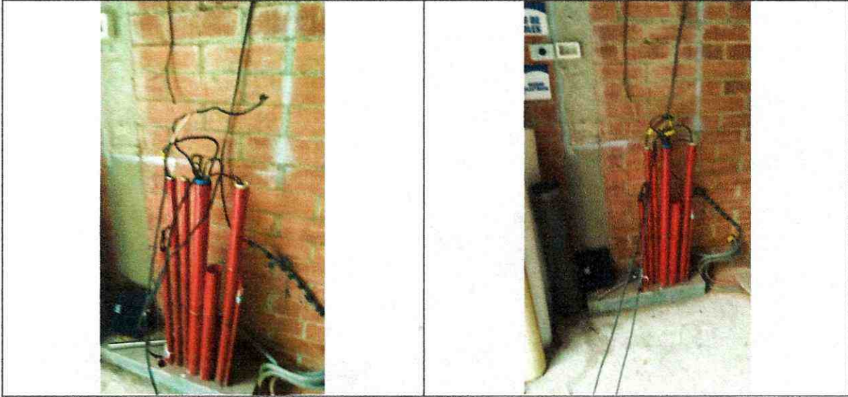
Conexión de equipos de medición de aire en ptar tejar
