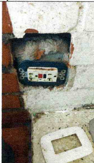
cambio de tomacorrientes GFCI en ptar Americas
