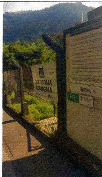
Cambio de iluminación de bocatoma combeima
