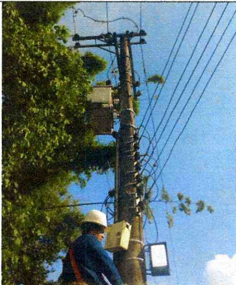
Cambio de iluminación de bocatoma combeima
