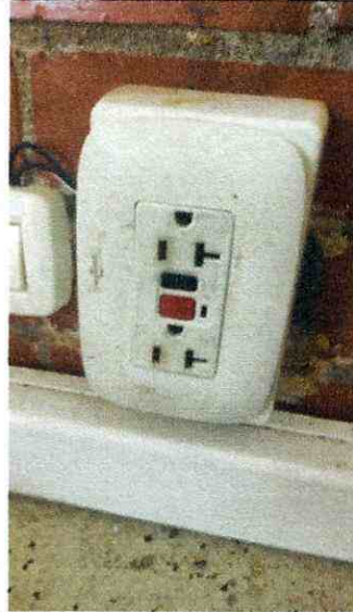
cambio de tomacorrientes GFCI en ptar Americas
