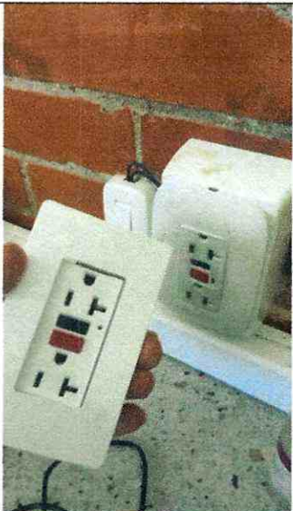
cambio de tomacorrientes GFCI en ptar Americas
