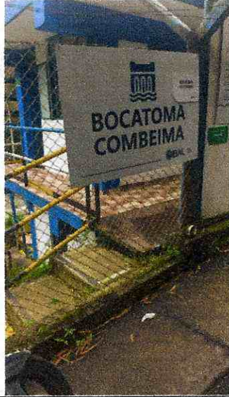
Mantenimiento planta combeima
