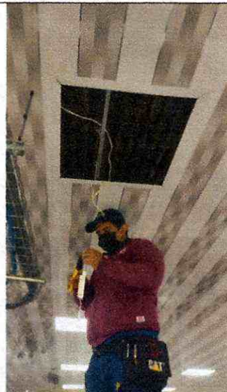
Adecuación de puntos de datos en oficinas de la 60
