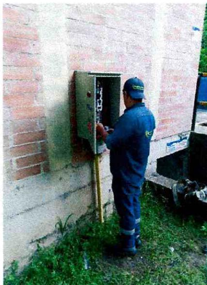
**18.** Cambio de luminaria en petar Comfenalco. Se requieren 9 reflectores de 100w para reparar la iluminación exterior de la ptar.
