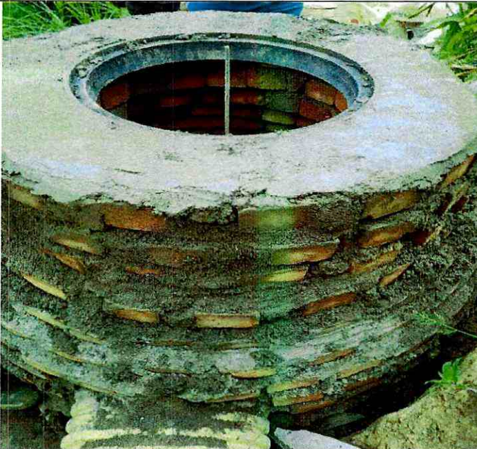
Ilustración 5. Construcción pozos de inspección
