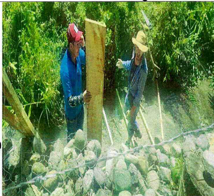
Ilustración 3. Construcción de gaviones
