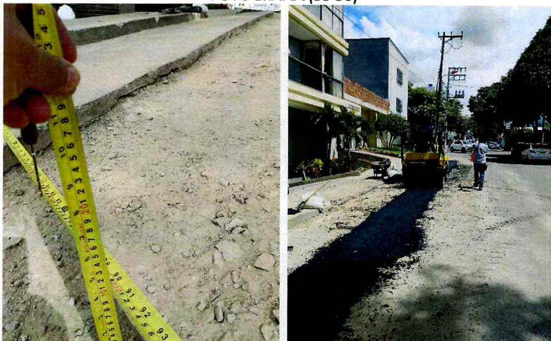
Suministro e instalación de la mezcla asfáltica para realizar el parcheo de la vía con su respectiva imprimación con una capa de 0,10 mt.
