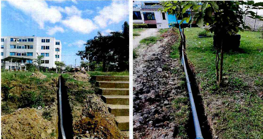
Excavaciones a mano en material común para la instalación de la tubería, suministro e instalación de la tubería PVC presión de 3 pulgadas para el mejoramiento de la presión de la red del barrio El Limón Salado.
