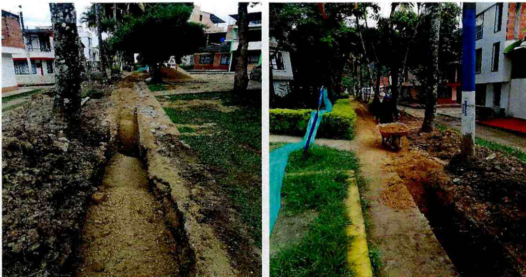
Suministro del material de recebo para el lleno de las excavaciones para la instalación de la tubería de 3" pulgadas frente al salon comunal del barrio San Luis Gonzaga.
