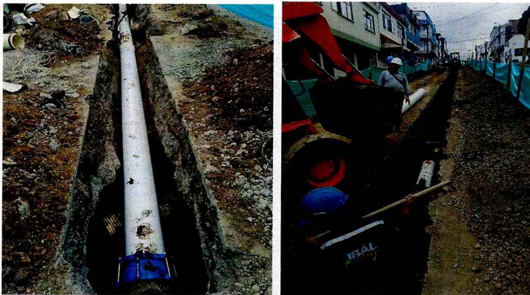
Suministro e instalación de la tubería PVC presión RDE 21 de 12" pulgadas en la red de conducción para la reparación de daños sobre la tubería de asbesto.
