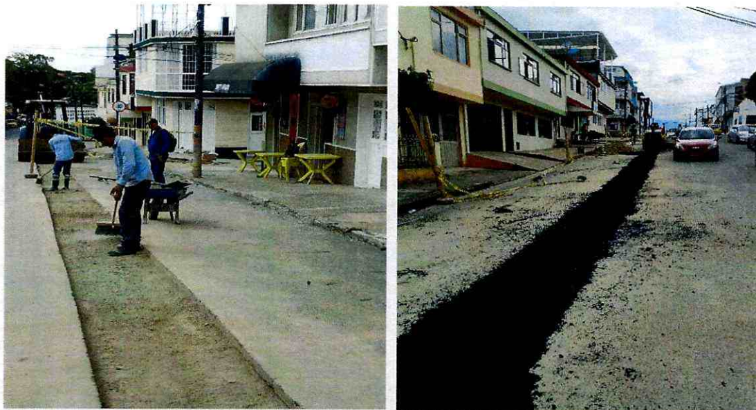
Suministro e instalación de la base granular para el mejoramiento de la estructura de la vía e imprimación y parcheo de la vía afectada.
