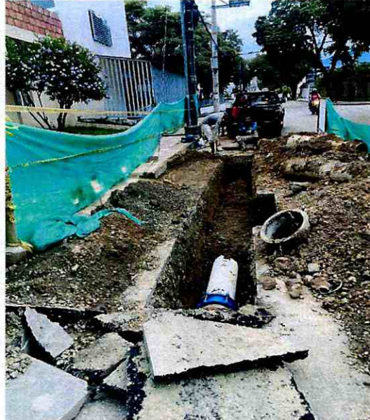
Suministro e instalación de la tubería de 12" pulgadas para realizar el arreglo de daños sobre la red de conducción en el tubo de asbesto cemento en la carrera 4H con calle 40 barrio la Macarena.
