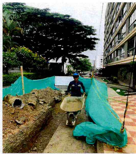
Suministro e instalación de la poli sombra para el cerramiento del tramo de 90 ml de longitud y lleno con material de recebo para la tubería de 12" pulgadas.
