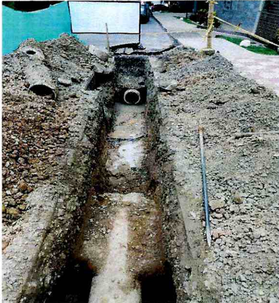
Suministro e instalación de la tubería de 12" pulgadas para realizar el arreglo de daños sobre la red de conducción en el tubo de asbesto cemento en la carrera 4H con calle 40 barrio la Macarena.
