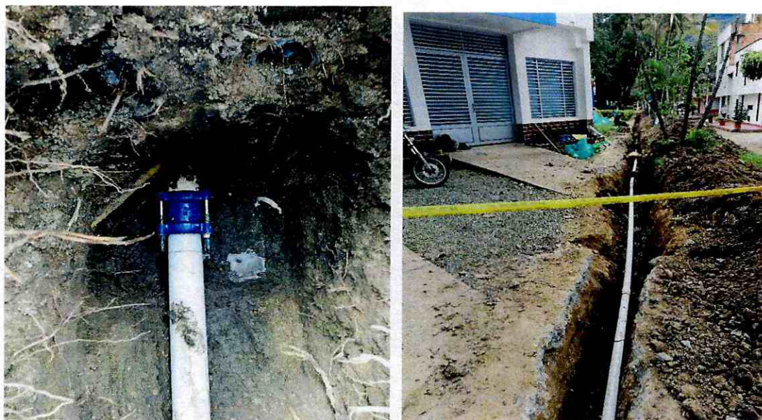
Suministro e instalación tubería PVC presión RDE 21 de 3" para el mejoramiento del servicio de acueducto del sector en el barrio San Luis Gonzaga frente al salón comunal del barrio.
