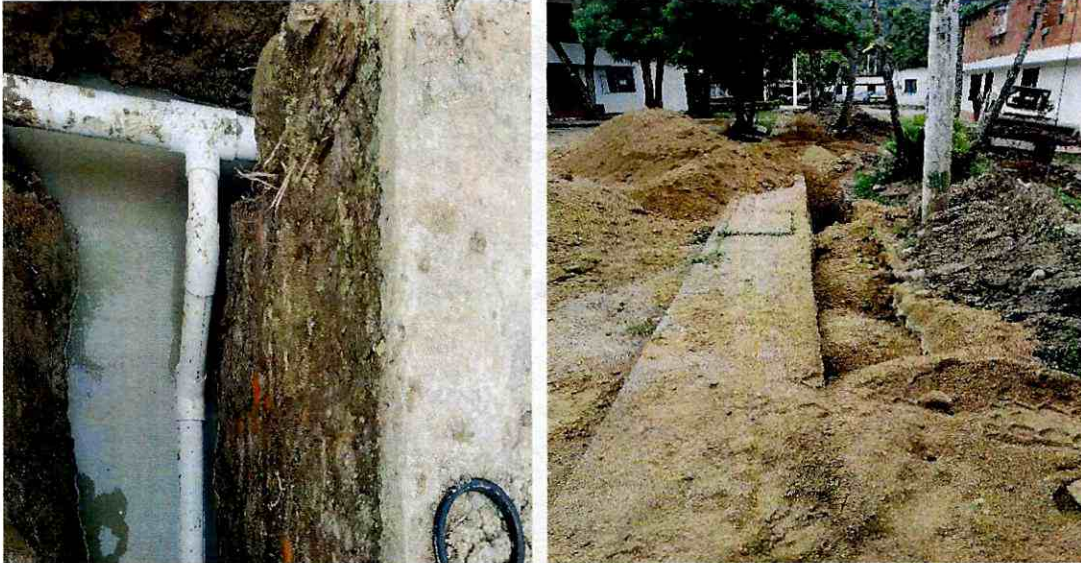
Suministro de accesorios de 3" pulgadas Tee y Semi Codos PVC presión para las derivaciones de la tubería de 3" pulgadas en el barrio San Luis Gonzaga
