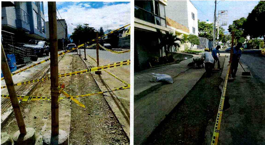
Suministro e instalación de la base granular para mejorar la estructura de la vía y barrido para imprimir para realizar el parcheo con asfalto.
