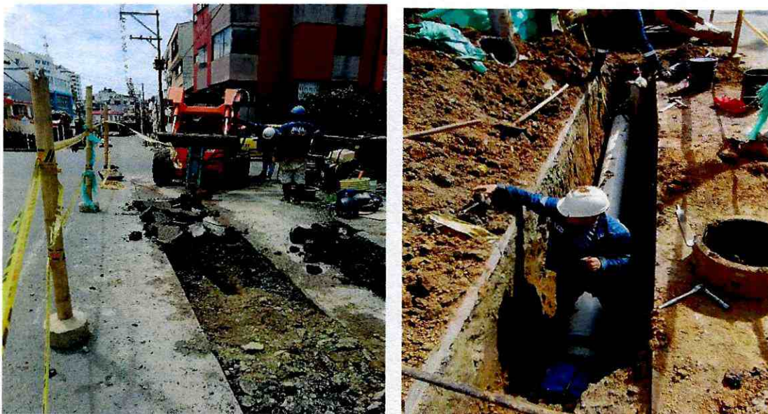
Arreglo de la red de conducción de 12" pulgadas con tubería PVC RDE 21 y con sus respectivos accesorios en la cr 4H con calle 36 en el barrio Cádiz
