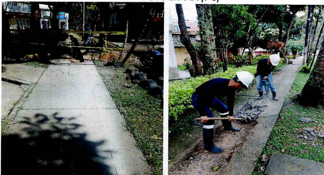
Corte con cortadora en andén y retiro de demoliciones en concreto para la reposición de la tubería en asbesto cemento de 3" pulgadas para el mejoramiento del servicio de acueducto del sector y barrios aledaños.
