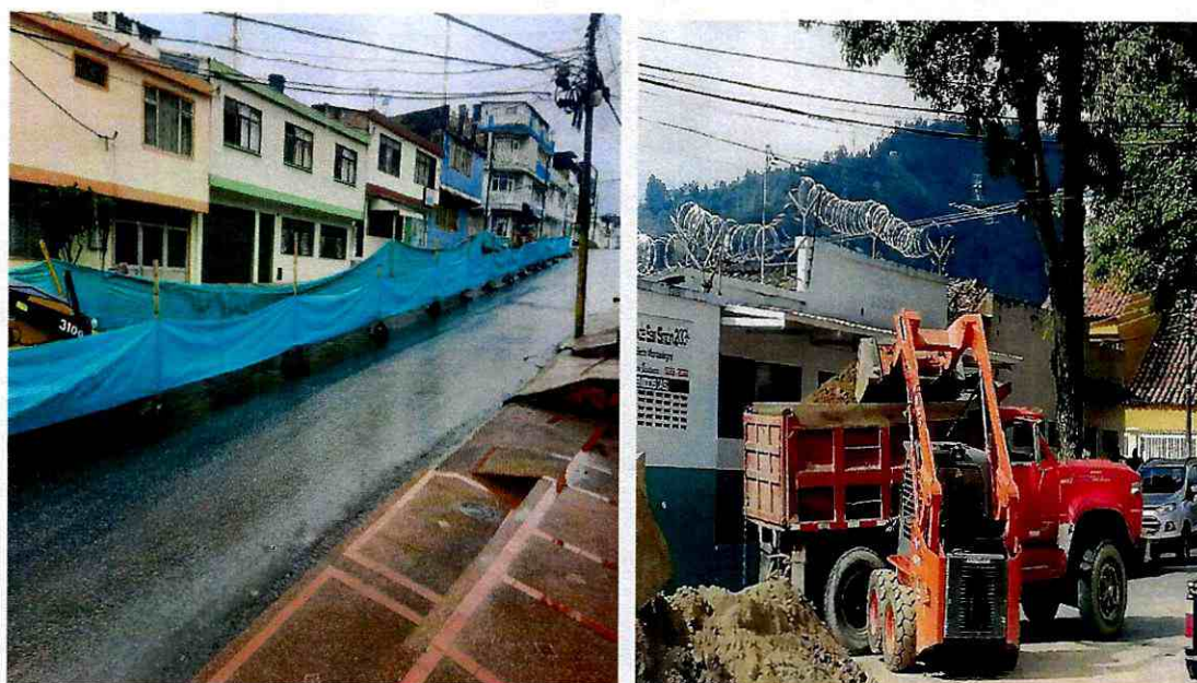
Poli sombra para el cerramiento del tramo en el barrio Magisterio y retiro de escombros y material de la excavación a la escombrera.
