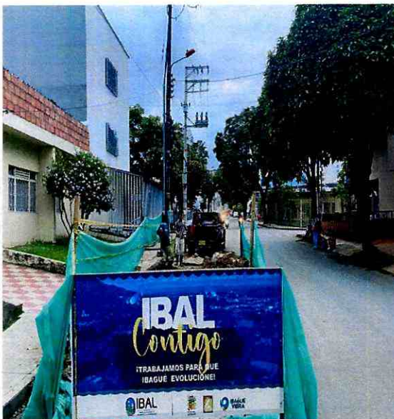
Suministro e instalación de la poli sombra para el cerramiento del tramo de 90 ml de longitud y lleno con material de recebo para la tubería de 12" pulgadas.
