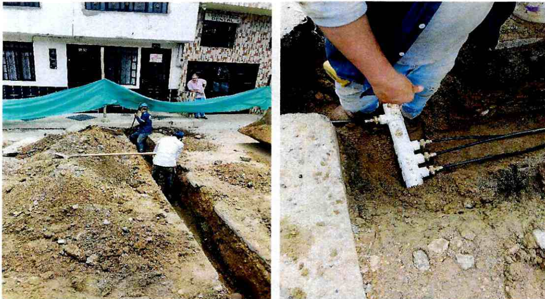
Excavaciones a mano para la instalación de las domiciliarias de acueducto e instalación de los accesorios para las domiciliarias y la manguera de 1/2" de presión
