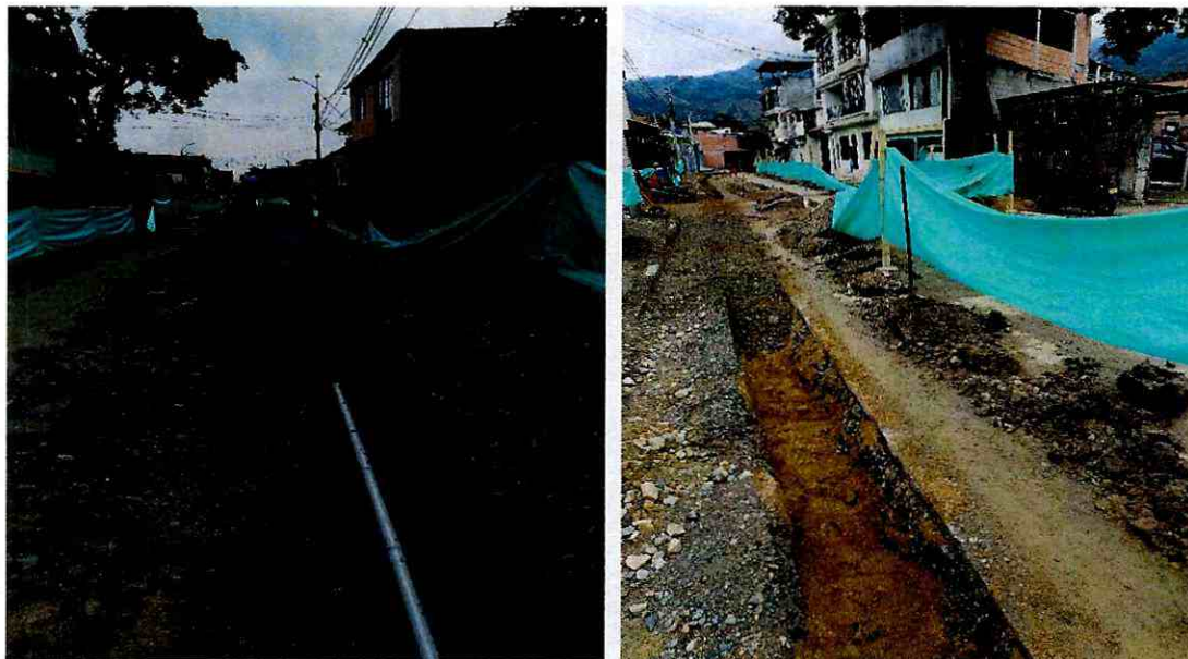
Suministro e instalacion de tuberi PVC presion de 3" pulgadas para la red de acueducto del sector de la calle 21 con carrera 13 del Ibal y llenos en material de recebo compactado mecanicamente hasta el nivel de pavimento .
