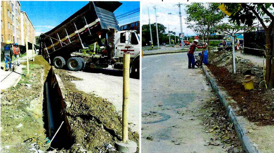
Suministro de material de recebo compactado mecánicamente para realizar el lleno de las excavaciones para la instalación de la tubería PVC presión de 6" pulgadas en el sector de la Arboleda Campestre.
