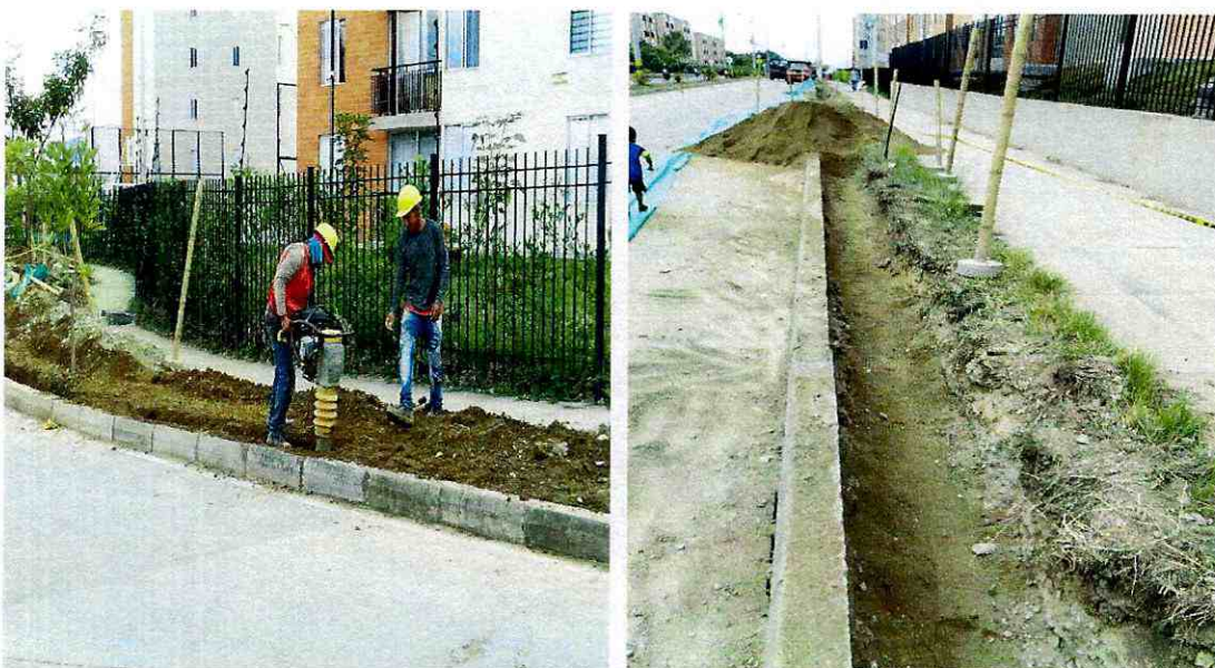
Suministro de material de recebo compactado mecánicamente a lo largo de las excavaciones para realizar el lleno de las mismas para la instalación de la tubería PVC presión de 6" pulgadas en el sector de la Arboleda Campestre.
