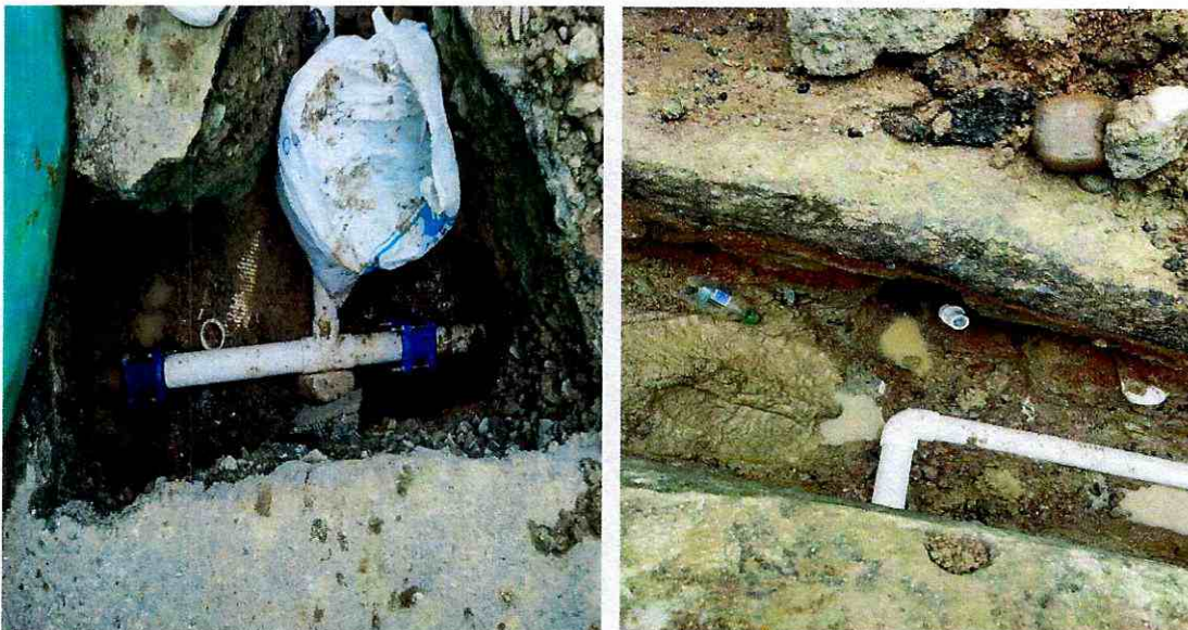
Suministro e instalación de unión dresser de 3" pulgadas, Tee PVC de 3" pulgadas y codo de 90° PVC del barrio San Pablo.
