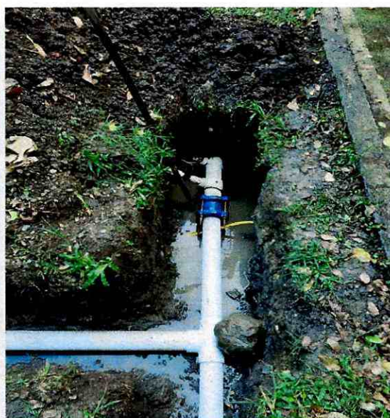
Instalación de universales de 3", codo de 90° PVC y collarines de 3 x 1/2, registros de incorporación bronce de 1/2" para las domiciliarias afectadas en el tramo de la Manzana F del barrio Villa Zulay.
