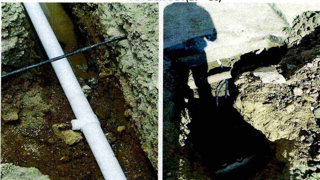
Instalación de collarin de 3 X 1/2", instalación de registro de incorporación de 1/2" en bronce, instalación de manguera de 1/2" de presión y unión Pf de media para la instalación de las acometidas del barrio Villa Luces del sector del Ricaurte.
