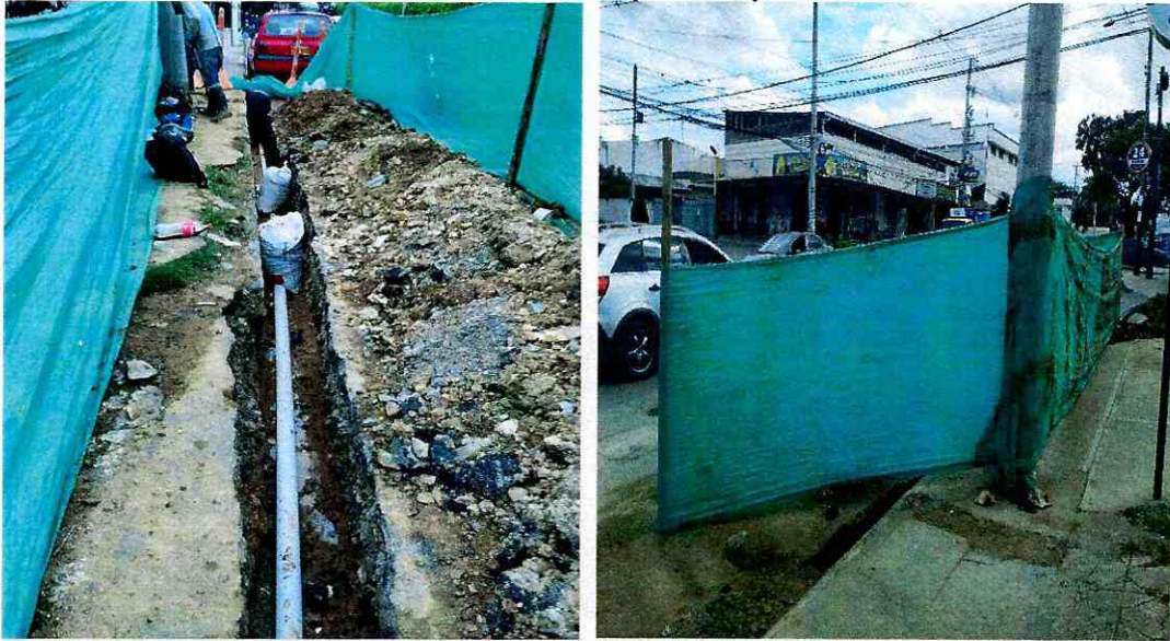
Cerramiento en poli sombra e instalación de tubería PVC presión de 2" y 3" pulgadas en el barrio San Pablo.
