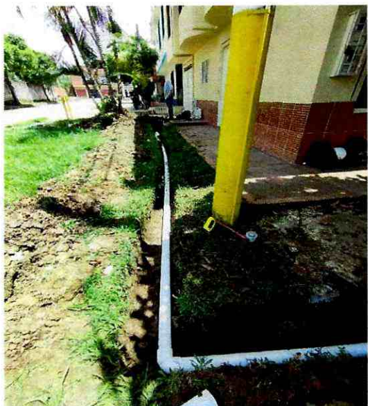
Instalación de universales de 3", codo de 90° PVC y collarines de 3 x 1/2, registros de incorporación bronce de 1/2" para las domiciliarias afectadas en el tramo de la Manzana F del barrio Villa Zulay.
