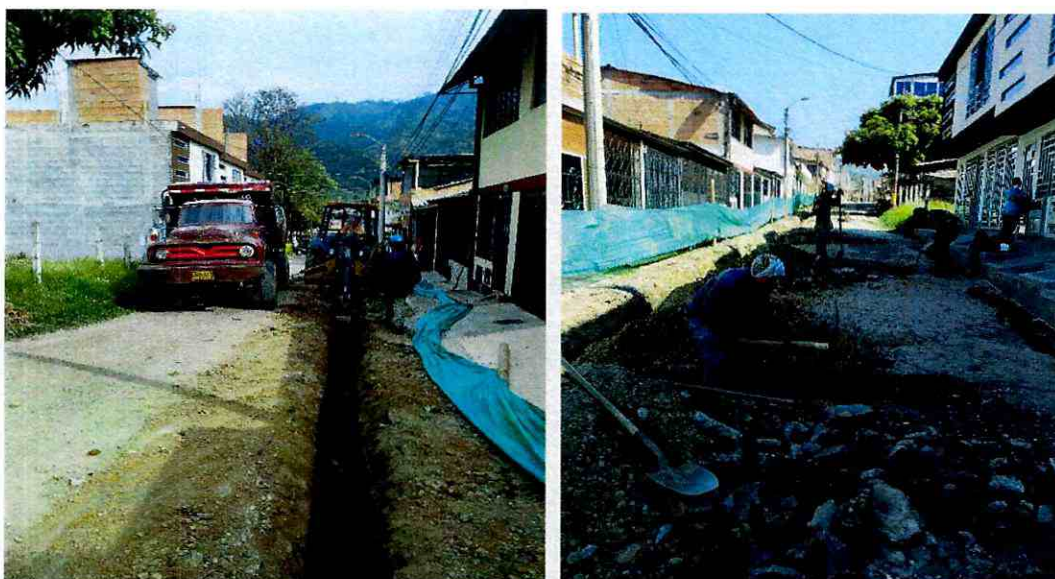
Excavaciones a máquina y excavaciones a mano, y retiro de sobrantes de las excavaciones de la red principal para la instalación de la tubería de 3" PVC presión en el Barrio Villa Luces del Sector del Ricaurte.
