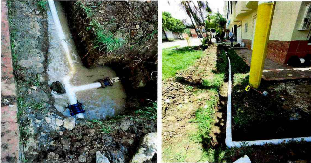
Instalación de tubería de 3" PVC presión RDE 21, con sus respectivos accesorios como universales o dresser de 3" pulgadas y codos de 90° PVC. En el barrio Villa Zulay.
