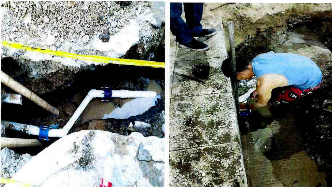
Suministro e instalación de semi codos de 45° PVC de 3" pulgadas y uniones dresser de 3" pulgadas para realizar los empalmes con la red existente en el barrio Villa Luces del sector del Ricaurte.
