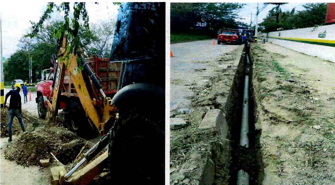
Excavaciones a máquina, retiro del material sobrante de las excavaciones e instalación de la tubería PVC presión de 6" pulgadas en el sector de la Arboleda Campestre para el mejoramiento del servicio de acueducto en el sector.
