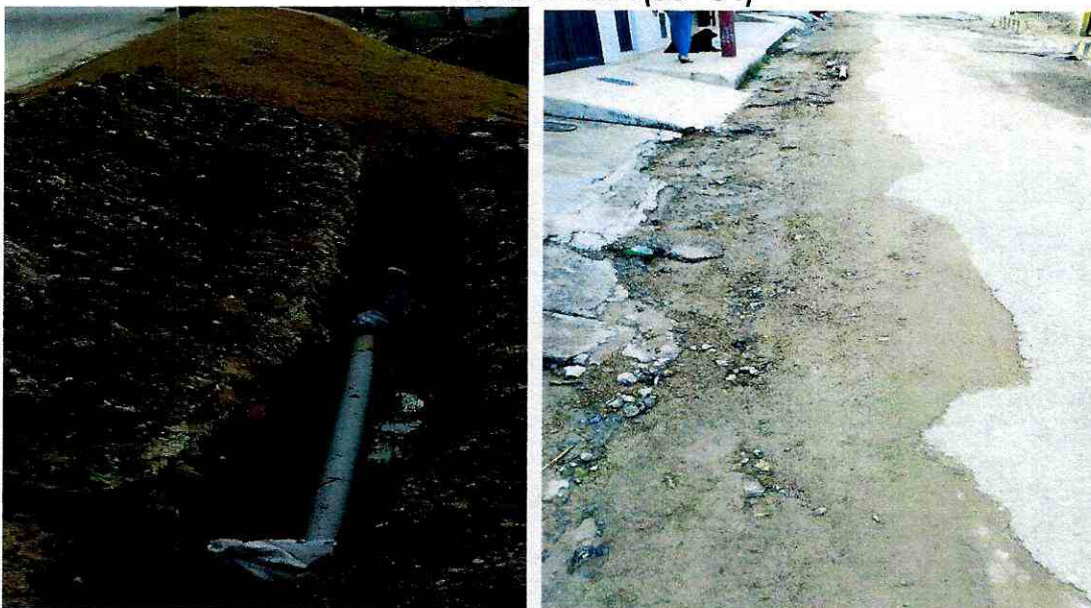
Suministro de recebo compactado mecánicamente para realizar el lleno de las excavaciones para la instalación de la tubería y suministro de recebo cemento para mejorar el nivel del lleno con el asfalto debido a que fue socavado por las lluvias
