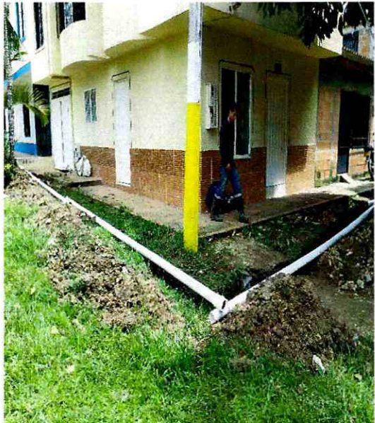
Instalacion de la tuberia de 3" Pulgadas presion RDE 21, instalacion de Tee PVC de 3" y semi codos de 45° para darle los giros necesarios a la tuberia y poder continuar con su instalacion.
