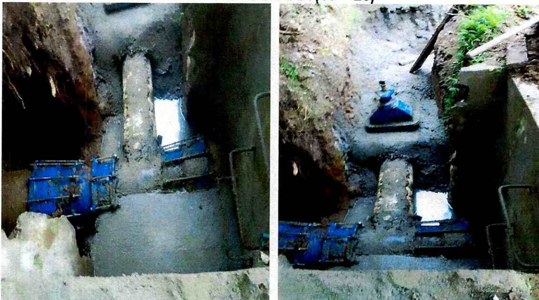
Concreto de 3.000 PSI para el atraque de los accesorios instalados en la instalación de la tubería de 16" para el mejoramiento del lleno del tanque la 30.
