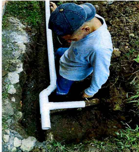
Instalacion de la tuberia de 3" Pulgadas presion RDE 21, instalacion de Tee PVC de 3" y semi codos de 45° para darle los giros necesarios a la tuberia y poder continuar con su instalacion.
