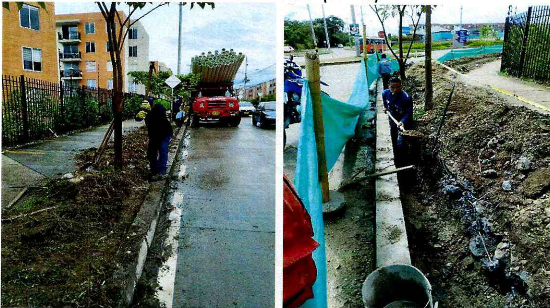
Excavaciones a mano, retiro del material sobrante y demoliciones de concreto debajo de la zona verde para la instalación de la tubería PVC presión de 6" pulgadas en el sector de la Arboleda Campestre.
