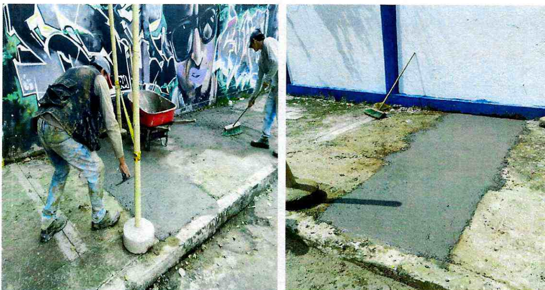
Suministro de concreto de 3.000 PSI para la recuperación de los andenes afectados en los tanques la 29 y la 30 para la instalación de la tubería de 16" pulg.
