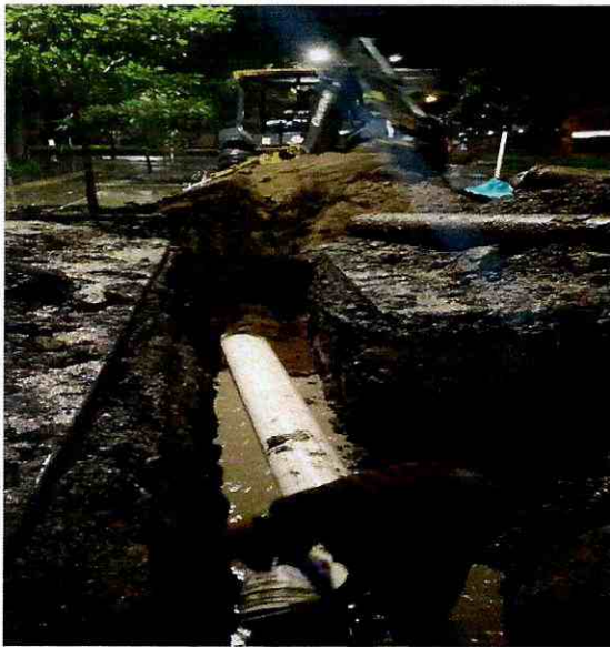
Suministro e instalación tubería PVC presión RDE 21 de 12" instalación de codo de 90° gran radio con sus respectivas universales de 12".
