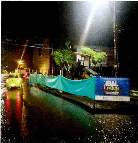
Instalación de la poli sombra para el cerramiento de las excavaciones en el sector y suministro de recebo cemento para mejorar el lleno y nivelar con el pavimento sobre la carrera 5 con calle 43
