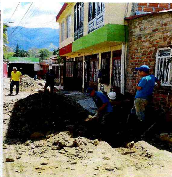
Excavaciones a mano sobre la carrera 14 ó 9 con calle 133 callejon CDI LOS PITUFOS para la instalacion de la tubería de 3" pulgadas para mejorar la presión por el sector.
