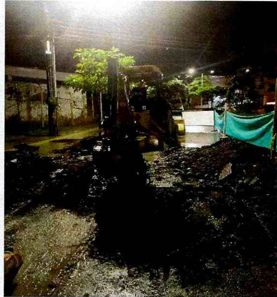
Corte y demolición del pavimento flexible y excavaciones a mano sobre la carrera 5 con calle 43 frente a la glorieta de presto
