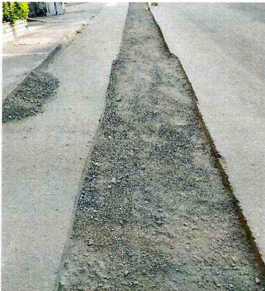
Suministro de base granular y mezcla asfáltica para la recuperación de la vía sobre la carrera 4H entre Calles 36 y 37
