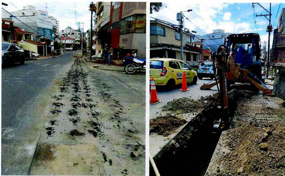
Corte, demolición de la carpeta asfáltica y excavaciones a máquina para la instalación de tubería de 12” PVC Presión RDE 21 para mejorar la red de conducción entre el tanque la 30 y el tanque de Piedra Pintada en la carrera 4H entre calles 36 y 37 Tramos 2.
