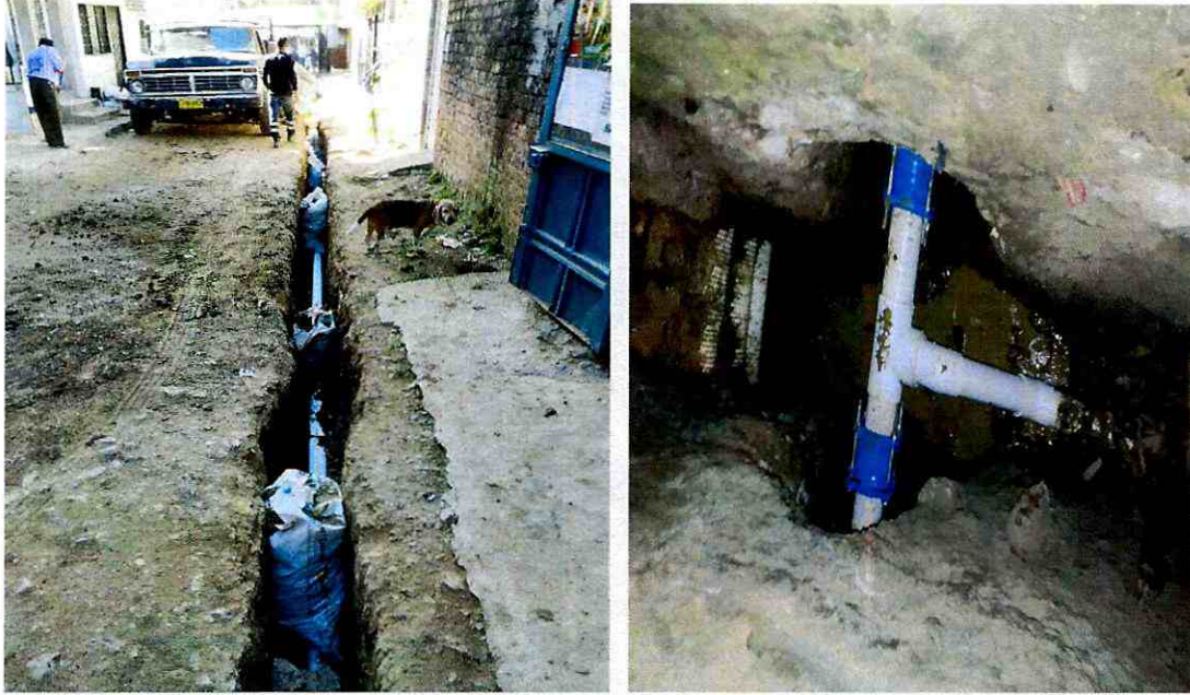
Suministro e instalación de tubería de 3" presión RDE 21 con sus respectivos accesorios como semi codos de 3" y Tee de 4" con universales mejorar la presión del sector que presenta deficiencias en el servicio de acueducto CDI los PITUFOS.
