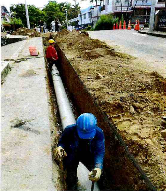
Instalacion de la tubería de 12" Pulgadas presion RDE 21 y llenos en material de recebo compactado mecanimanete para el mejoramiento de la red de conduccion entre el tanque la 30 y el tanque de piedrapintada.
