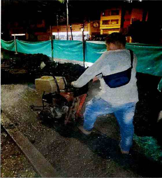
Corte y demolición del pavimento flexible y excavaciones a mano sobre la carrera 5 con calle 43 frente a la glorieta de presto
