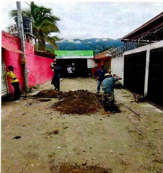
Excavaciones a mano sobre la carrera 14 ó 9 con calle 133 callejon CDI LOS PITUFOS para la instalacion de la tubería de 3" pulgadas para mejorar la presión por el sector.
