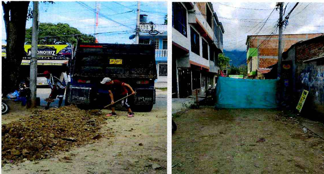
Retiro del material de las excavaciones a mano y cerramiento con poli sombra de la vía afectada por las excavaciones manuales para la instalación de la tubería de 3".
