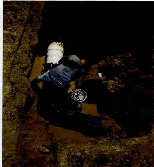
Suministro e instalación tubería PVC presión RDE 21 de 12" instalación de codo de 90° gran radio con sus respectivas universales de 12".
