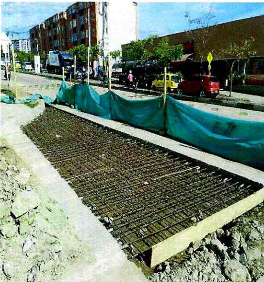
Suministro e instalación de acero de refuerzo para la recuperación de los concretos afectados sobre las vías y rampa de acceso a los conjuntos.
