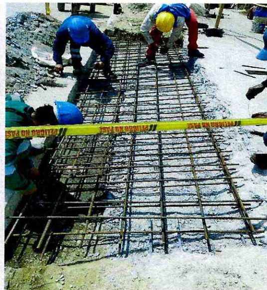
Suministro e instalación de acero de refuerzo para la recuperación de los concretos afectados sobre las vías y rampa de acceso a los conjuntos.
