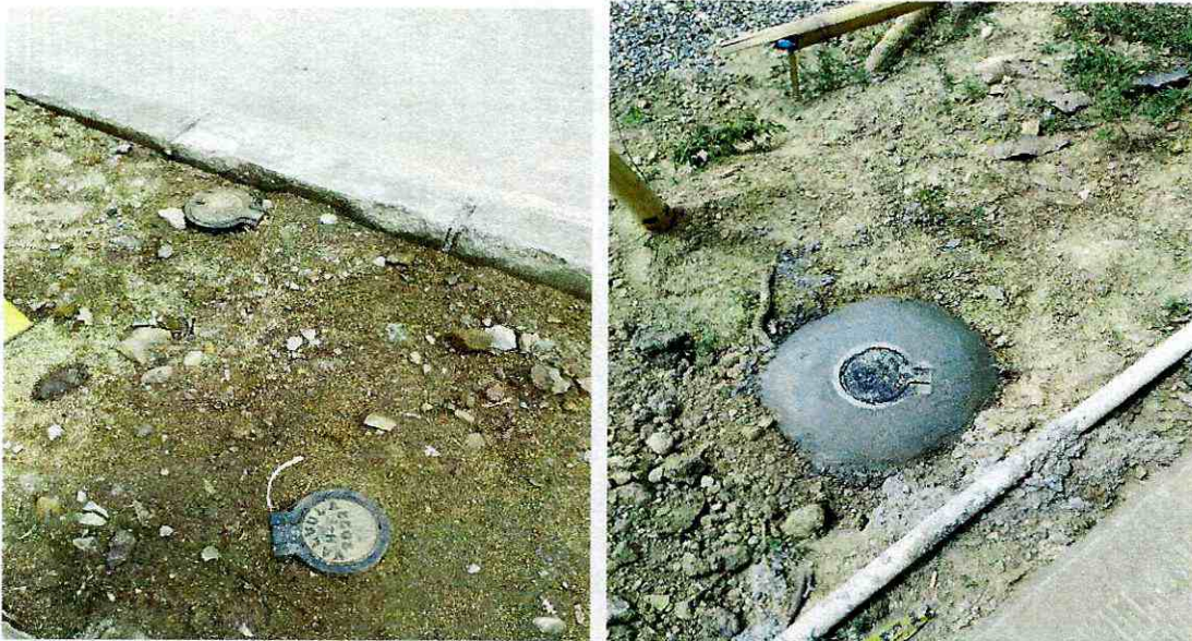
Suministro e instalación de Tapa válvulas para las Válvulas instaladas de 6", 4" y 3" en el sector de la Arboleda Campestre.
