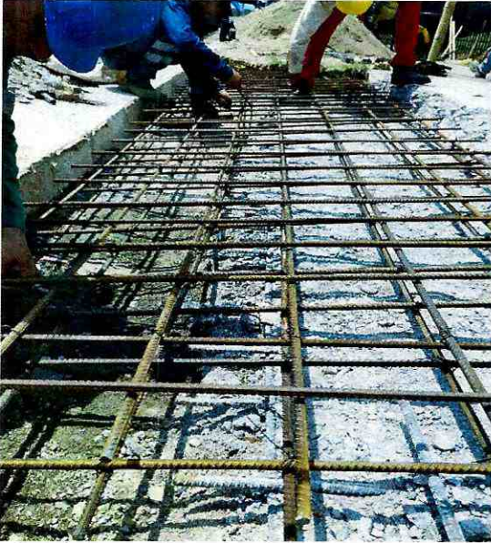
Suministro e instalación de acero de refuerzo de 60.000 PSI para la fundida de las rampas de acceso para las bodegas de la constructora bolivar, el conjunto la ceiba y la recuperación de algunas vías afectadas por la instalación de la tubería de 6" pulgadas.
