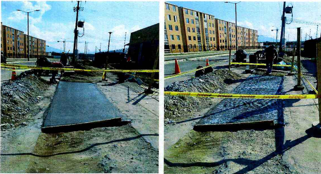
Suministro e instalación de concreto de 4.500 con acero de refuerzo de 60.000 PSI para la reposición de algunos concretos afectados por la instalación de la tubería de 6" pulgadas para mejorar el servicio en el sector de la Arboleda Campestre.
