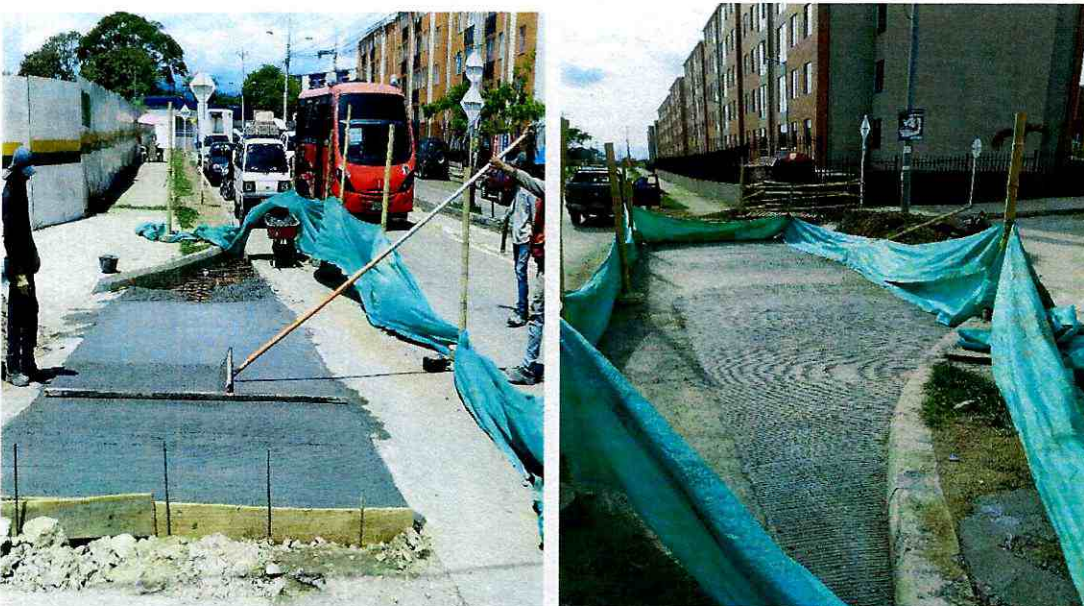
Suministro e instalación del concreto de 4.500 PSI con el acero de refuerzo para la recuperación de algunas vías afectadas y rampas de acceso a los conjuntos del sector la Arboleda Campestre.
