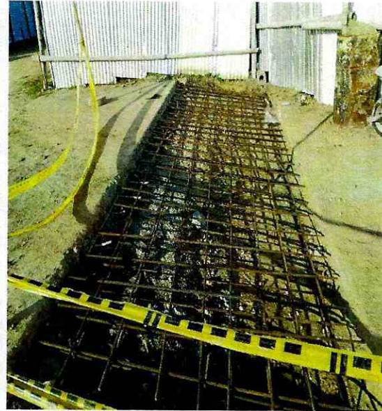
Suministro e instalación de acero de refuerzo de 60.000 PSI para la fundida de las rampas de acceso para las bodegas de la constructora bolivar, el conjunto la ceiba y la recuperación de algunas vías afectadas por la instalación de la tubería de 6" pulgadas.
