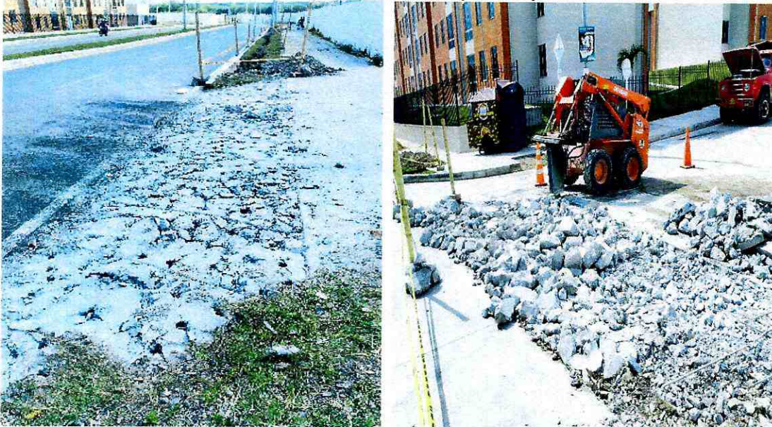
Demoliciones de vía existente en concreto reforzado para realizar los cruces de la tubería PVC presión de 6" pulgadas para el mejoramiento del acueducto en el sector de la Arboleda Campestre.
