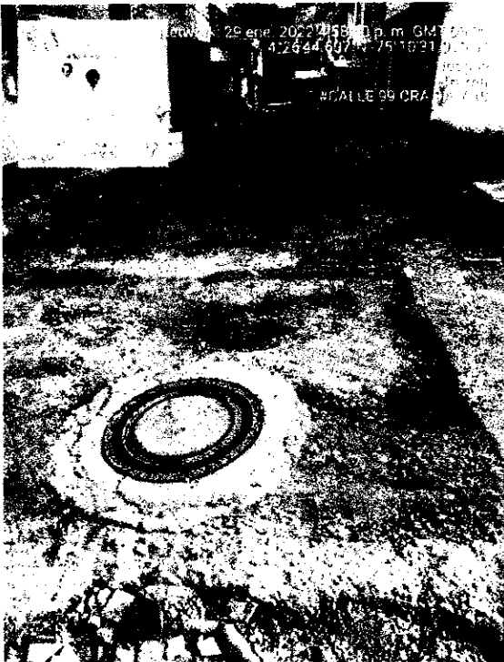
CALLE 99 ENTRE CARRERA 9A Y 10
