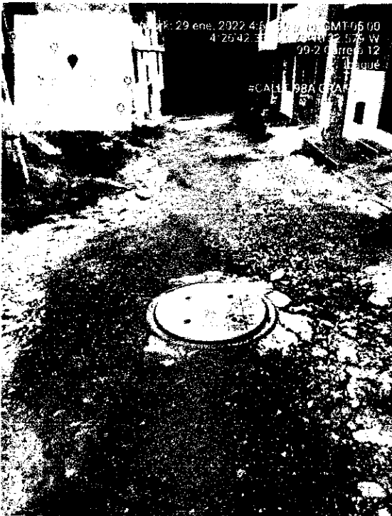
CALLE 98A ENTRE CRA 9A Y 9
