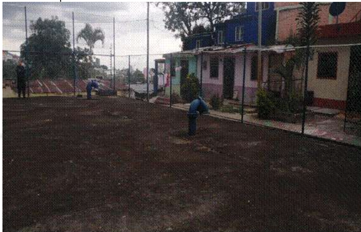
Cerramiento perimetral oriente.
