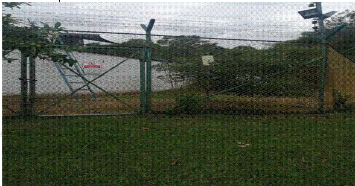
Cerramiento perimetral oriente.
