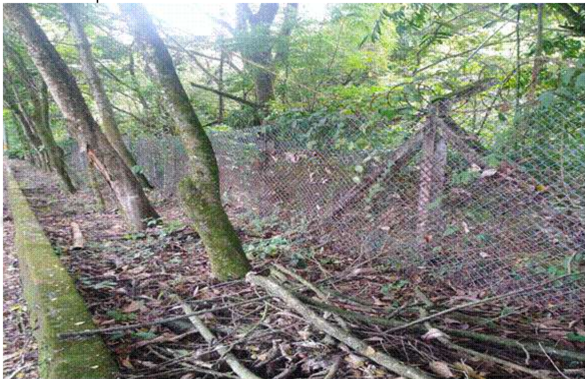
Cerramiento perimetral oriente.
