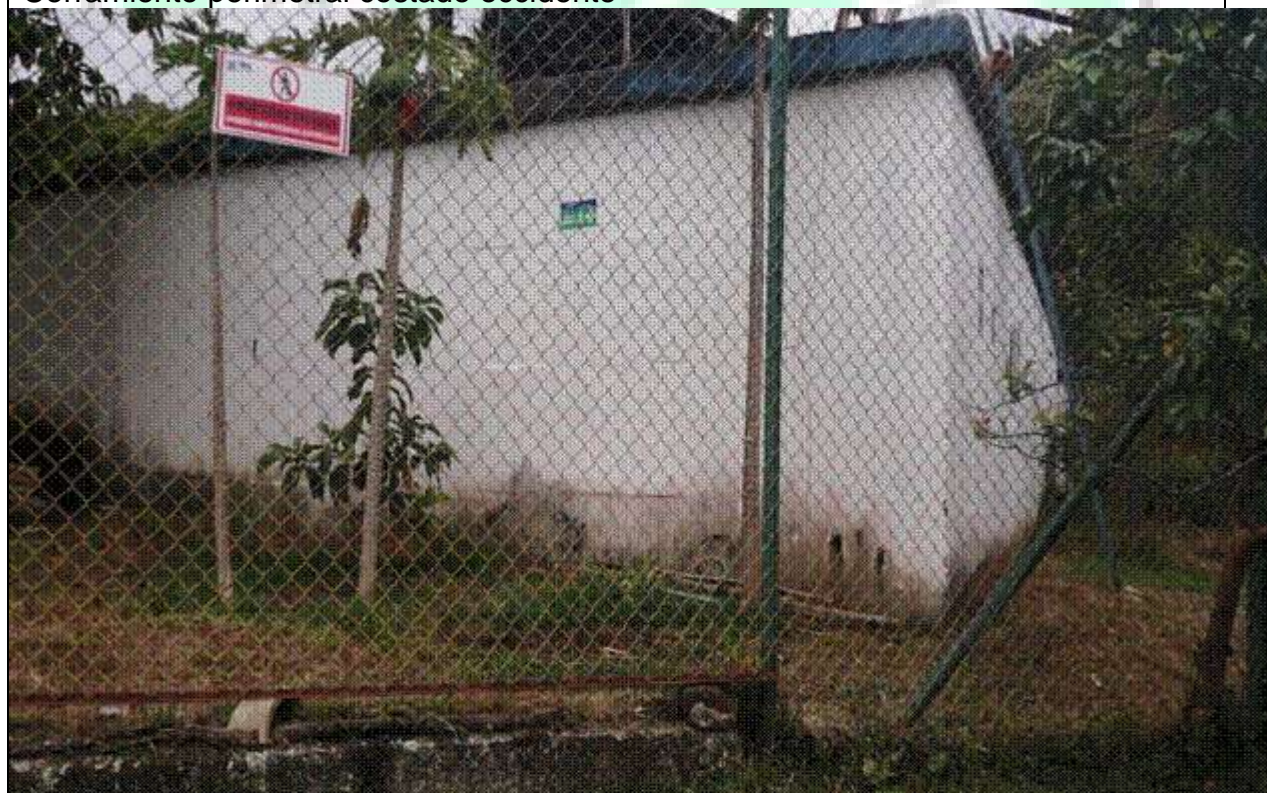
Cerramiento perimetral costado occidente
