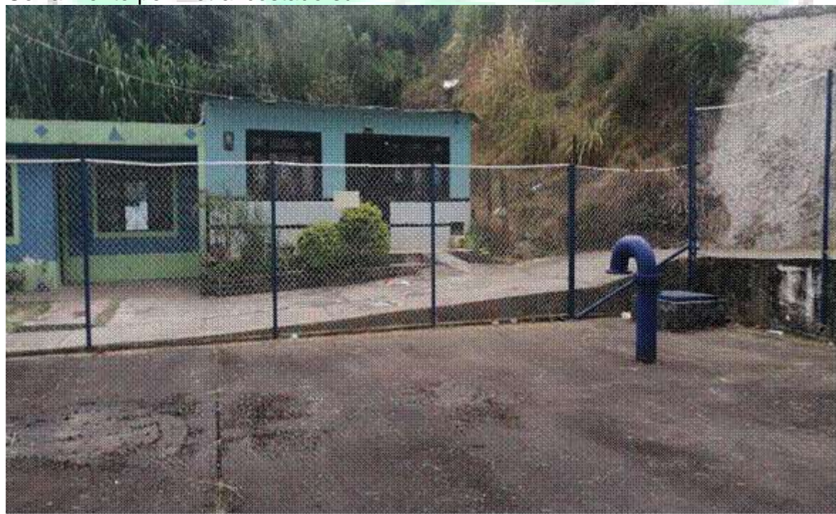
Cerramiento perimetral costado sur.
