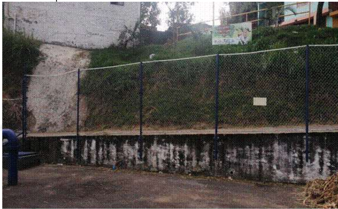
Cerramiento perimetral costado norte.
