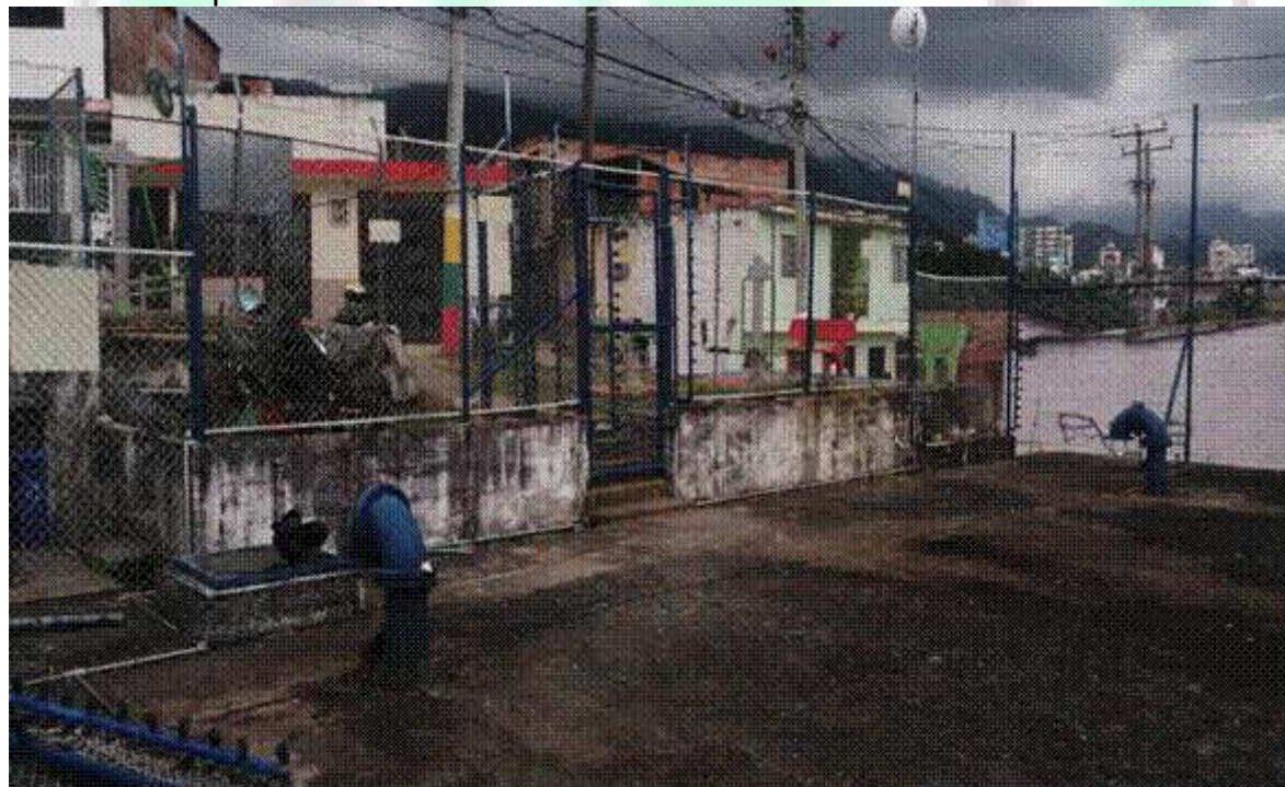
Cerramiento perimetral costado occidente
