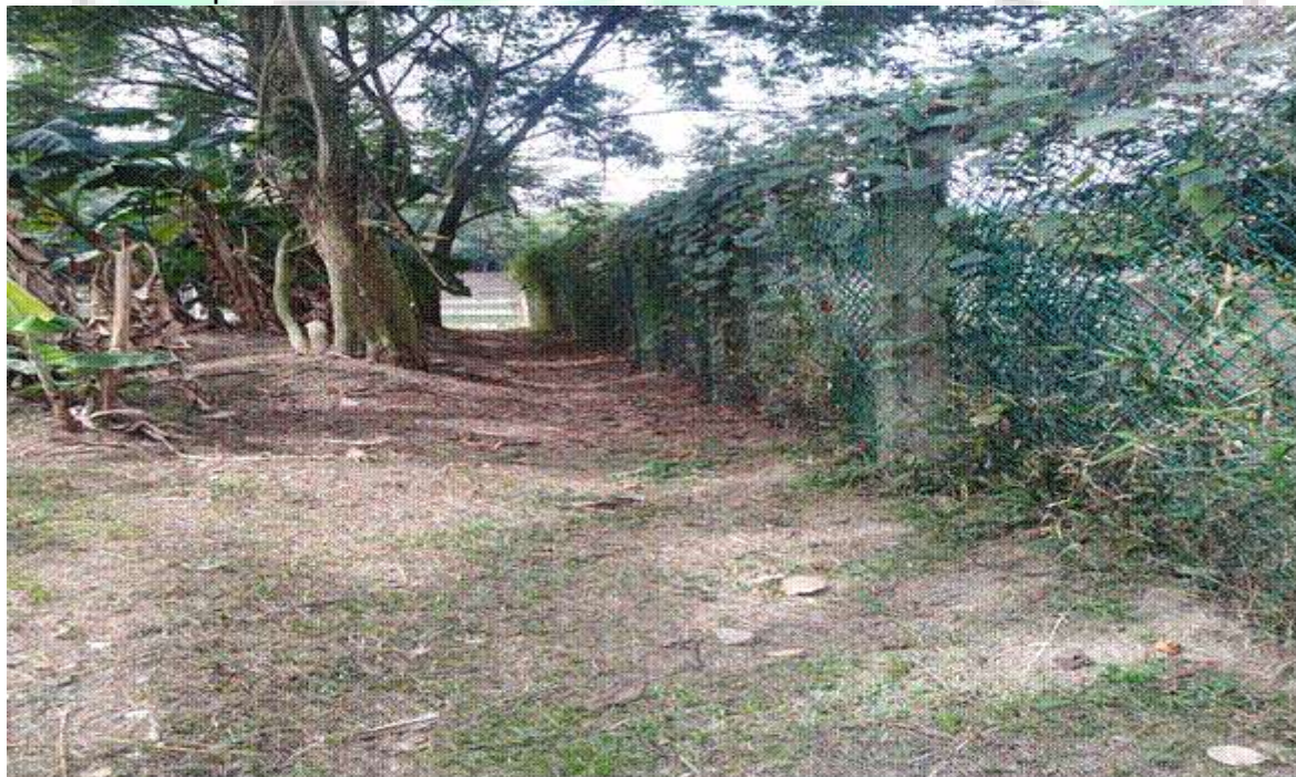
Cerramiento perimetral costado occidente
