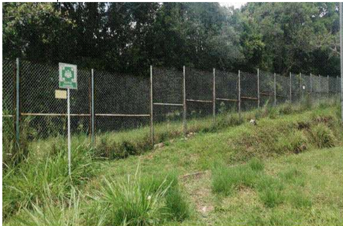
Cerramiento perimetral oriente.
