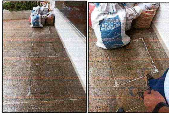
Imagen 3. Cajas de inspección selladas
