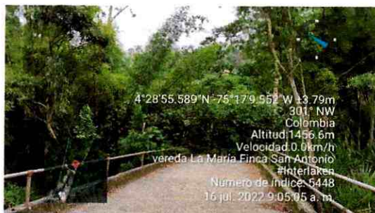
PUENTE DE ACCESO
