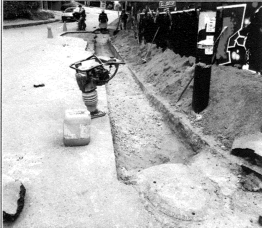
Cargue, suministro, extendida y compactacion de Base Granular (CARRERA 5 CALLE 3)
