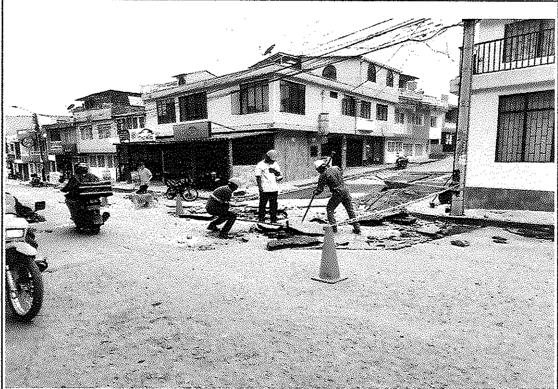
Demolicion de carpeta asfaltica (La floresta frente al parque)
