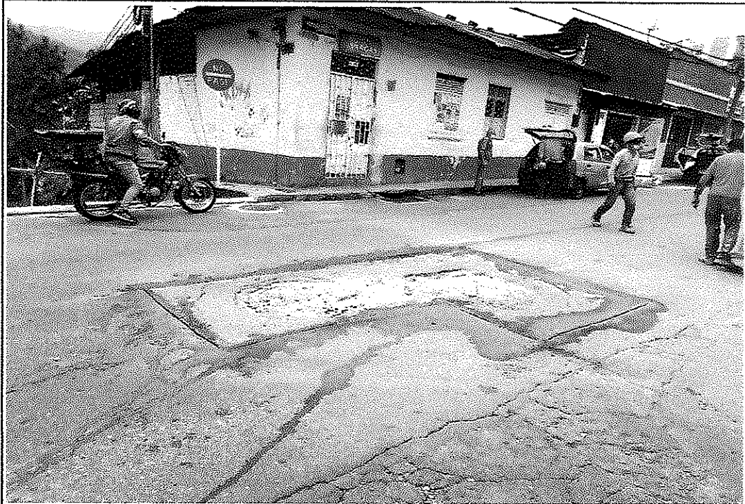
Corte de pavimento flexible con cortadora (Carrera 3ra calle 4)
