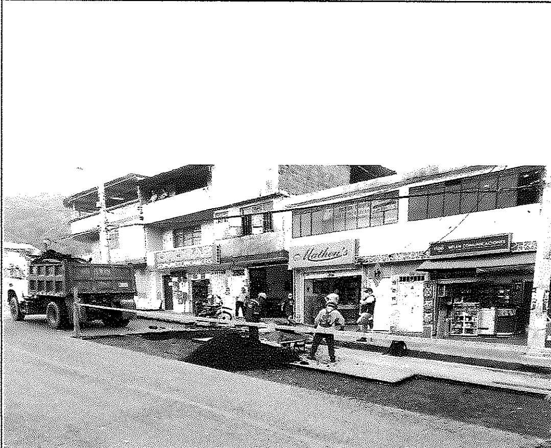
Parqueo de Pavimento asfaltico (CRA 10 CALLE 4A-19)
