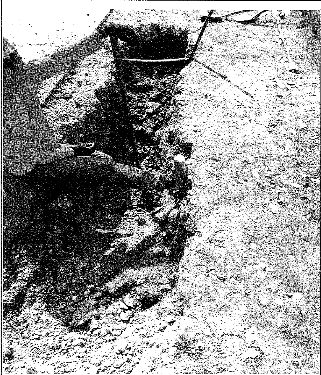
Aplicación y compactacion de base granular (LA FLORESTA CALLE 59 3-09)
