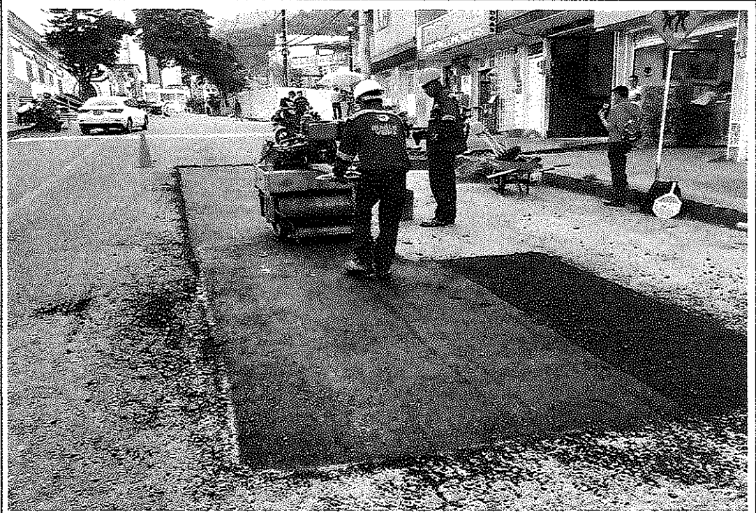
Parqueo de Pavimento asfaltico (CRA 10 CALLE 4A-19)
