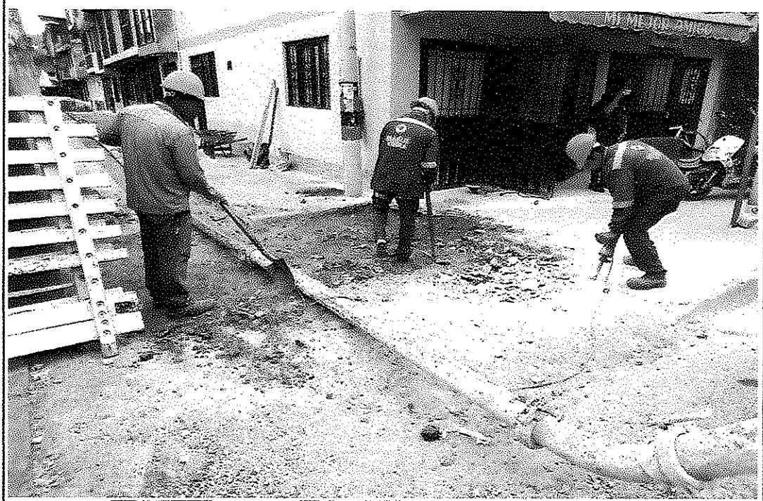
Rotura de concreto rigido (EL SALADO CALLE 125)
