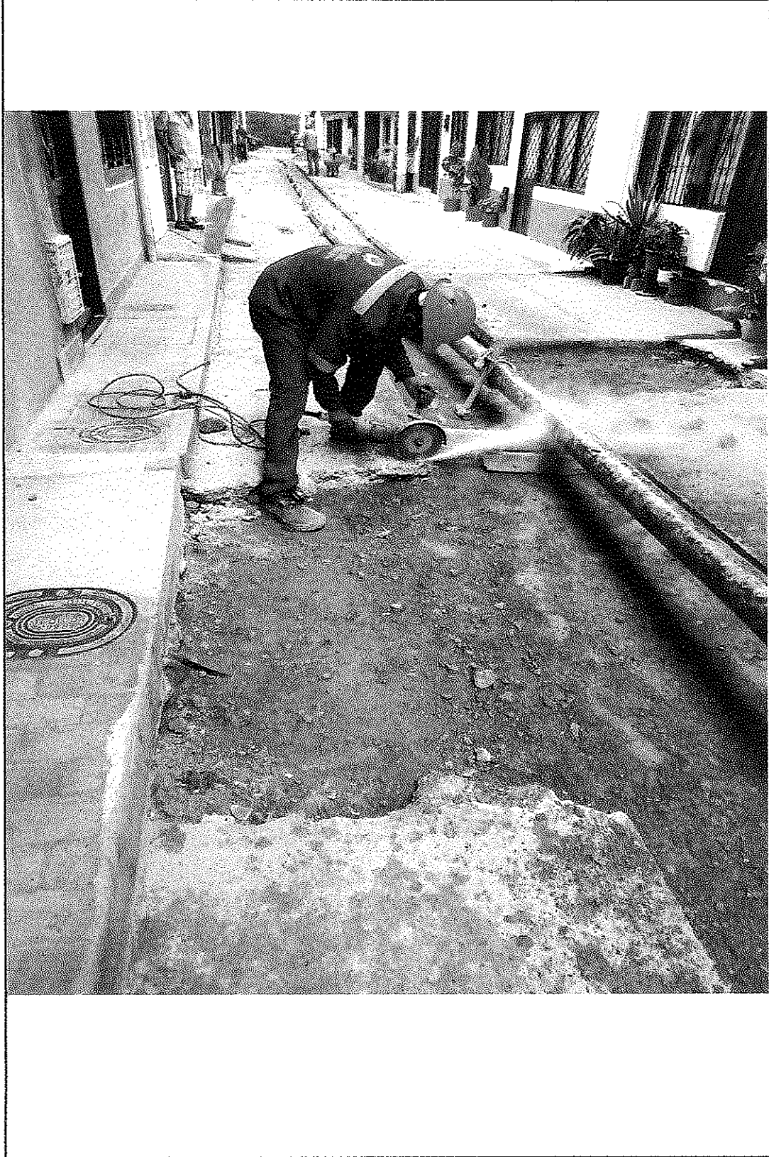
Corte de pavimento rigido con cortadora (EL SALADO CALLE 125)
