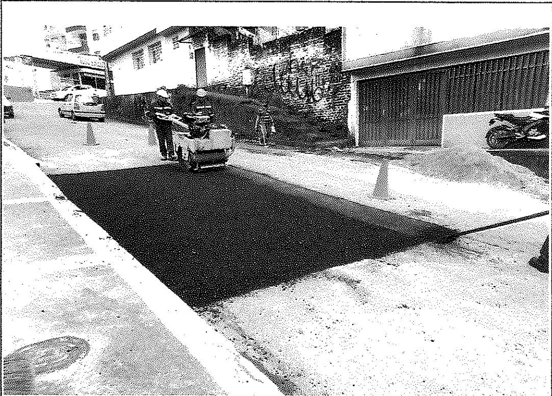
Parqueo de Pavimento asfaltico (CRA 5 CALLE 3-19)
