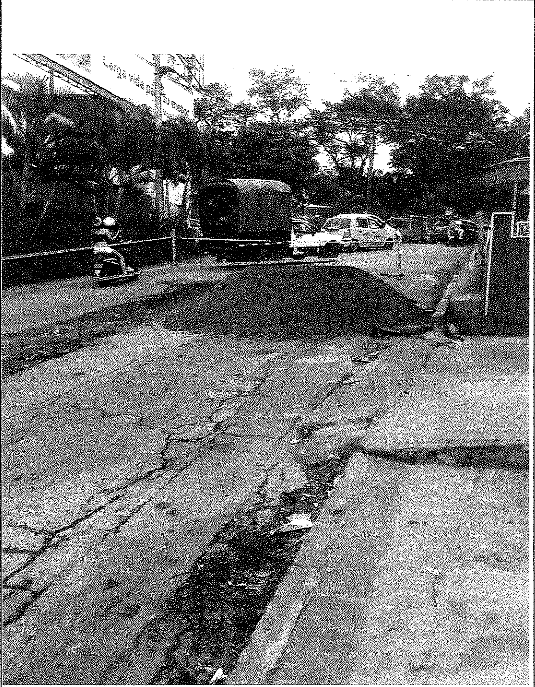
Cargue, suministro, extendida y compactacion de Base Granular (CALLE 35 CON FERROCARRIL)
