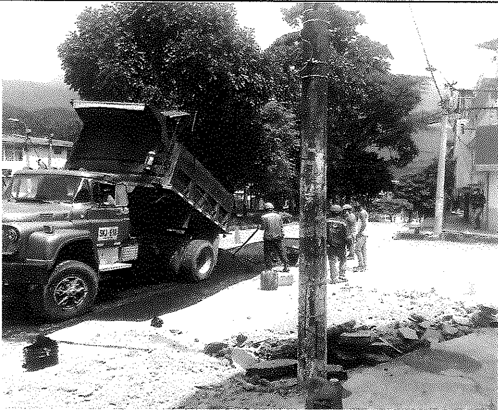
Aplicación de mezcla asfáltica (CALLE 26 ENTRE 6TA Y 7MA)
