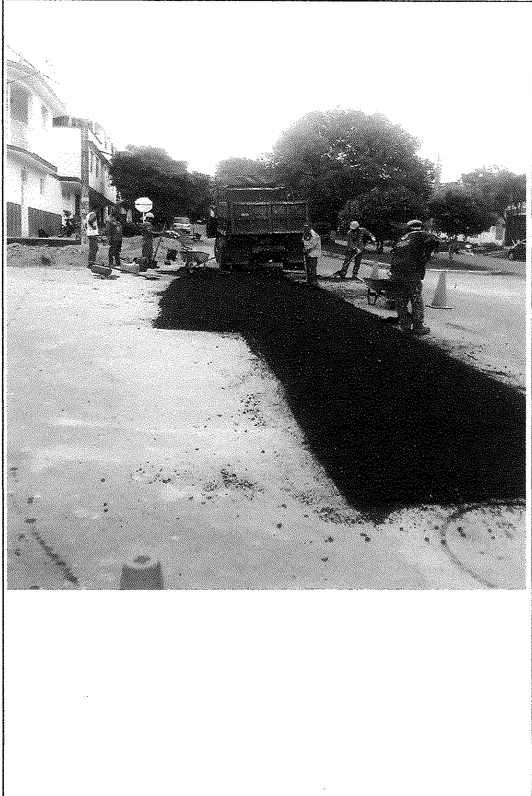
Aplicación de mezcla asfáltica (CALLE 26 ENTRE 6TA Y 7MA)
