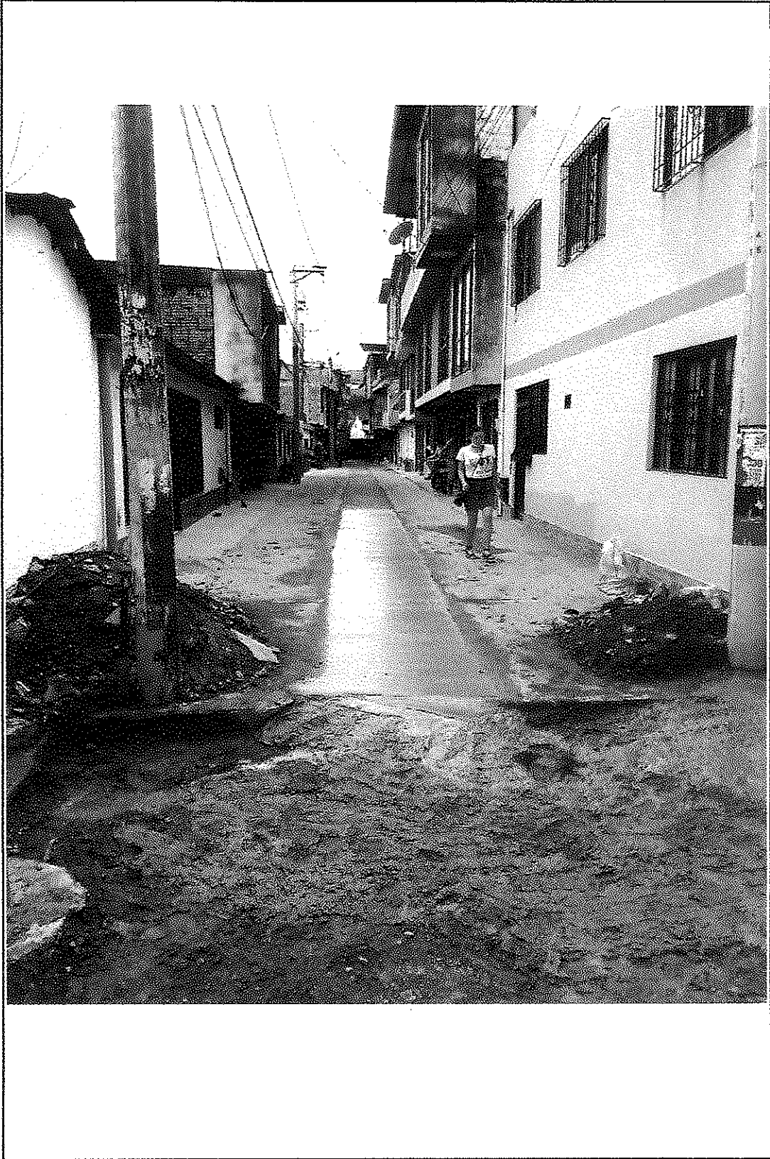
Construccion de placa de concreto de e= 15 cm (EL SALADO CALLE 125)
