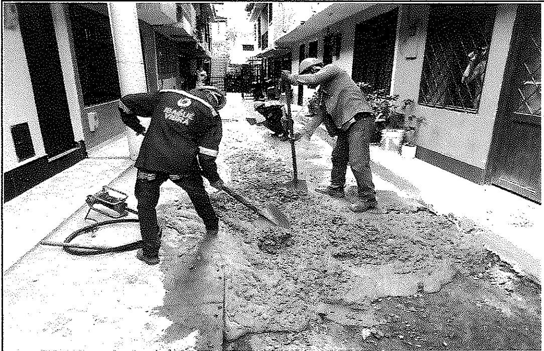
Construccion de placa de concreto de e= 15 cm (EL SALADO CALLE 125)
