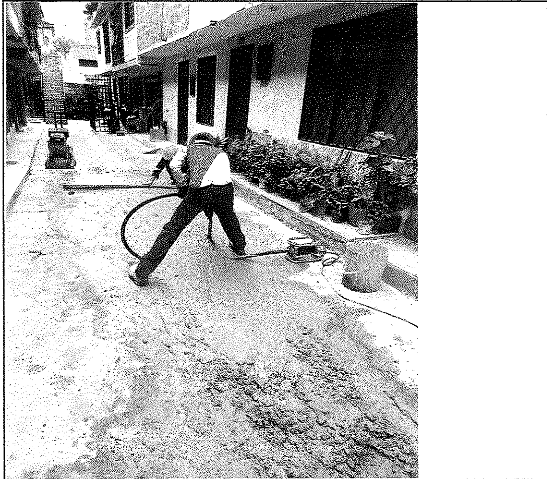
Construccion de placa de concreto de e= 15 cm (EL SALADO CALLE 125)
