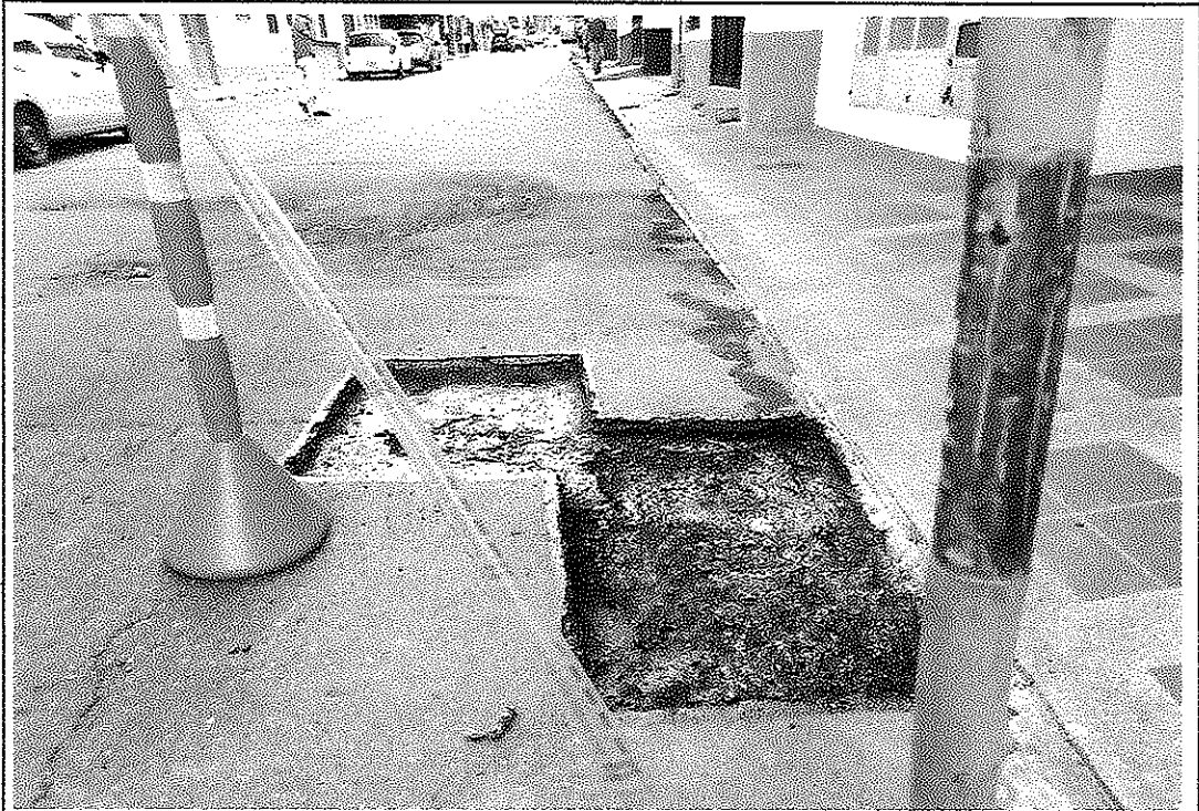
Parqueo de Pavimento asfaltico (CRA 3 CALLE 4-112)
