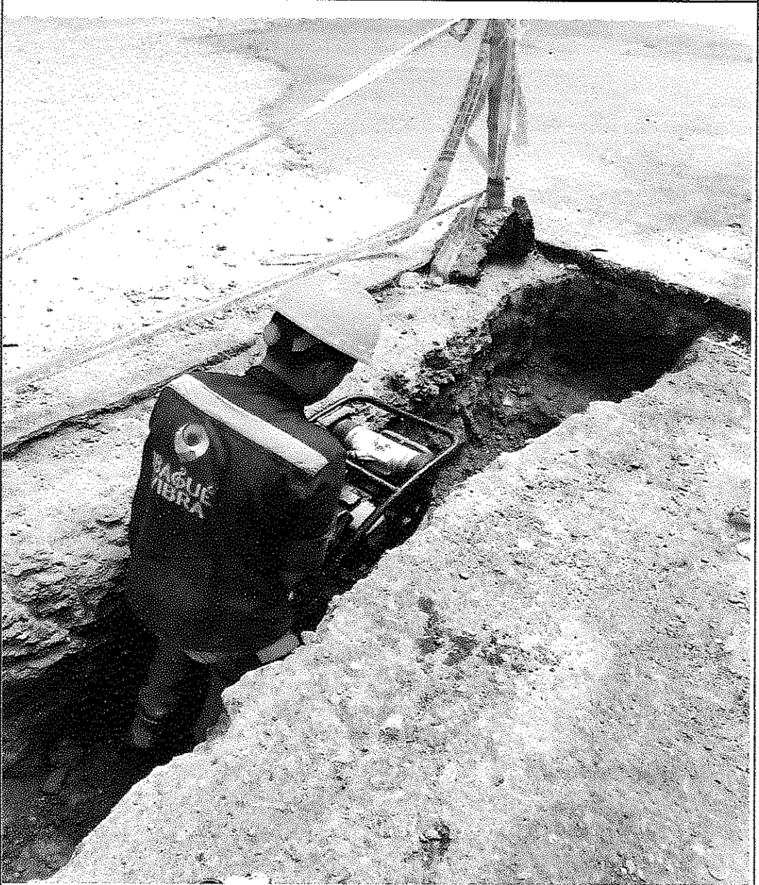
Aplicación y compactación de base granular (LA FLORESTA CALLE 59 3-09)
