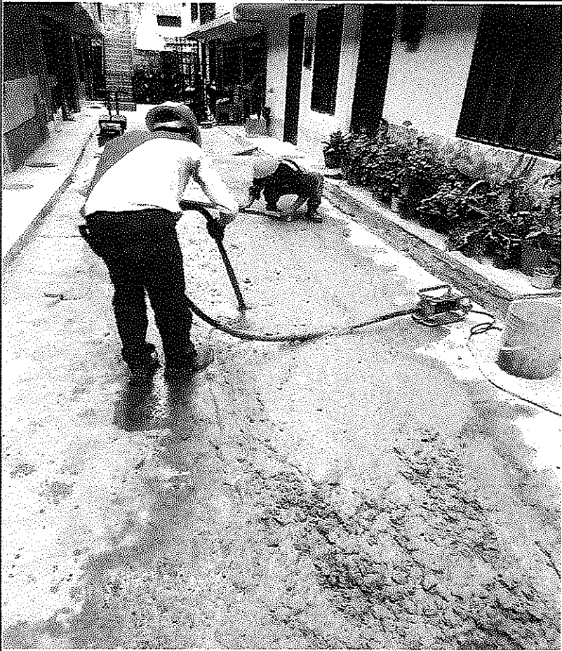
Construccion de placa de concreto de e= 15 cm (EL SALADO CALLE 125)
