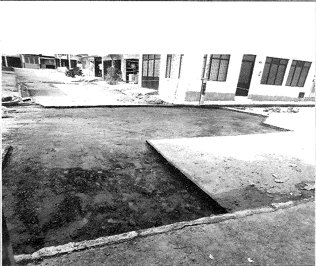
Parqueo de Pavimento asfaltico (LA FLORESTA FRENTE AL PARQUE)
