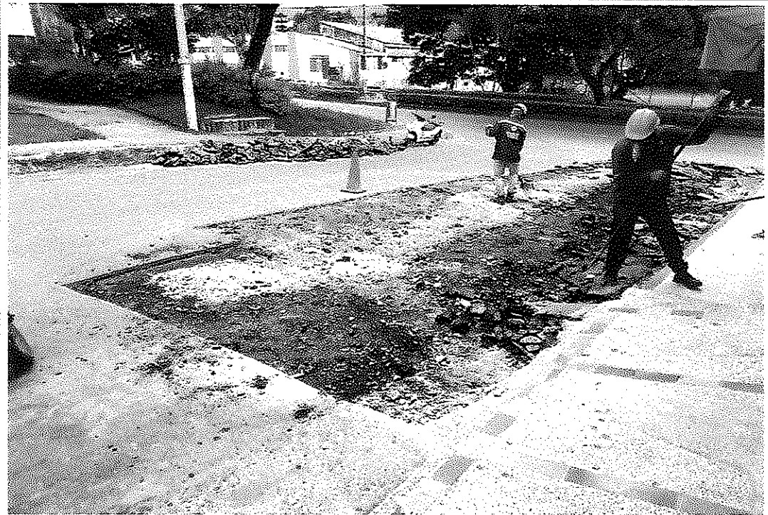
Demolicion de carpeta asfaltica (LA FLORESTA CRA 2A CALLE 59-72)
