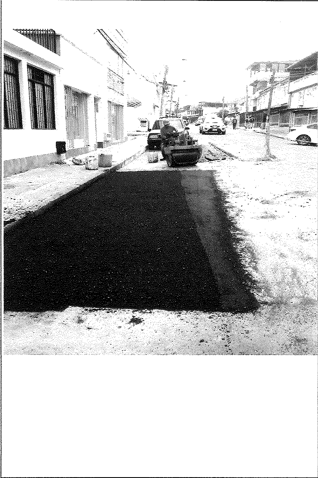
Parqueo de Pavimento asfaltico (LA FLORESTA CALLE 59 3-09)
