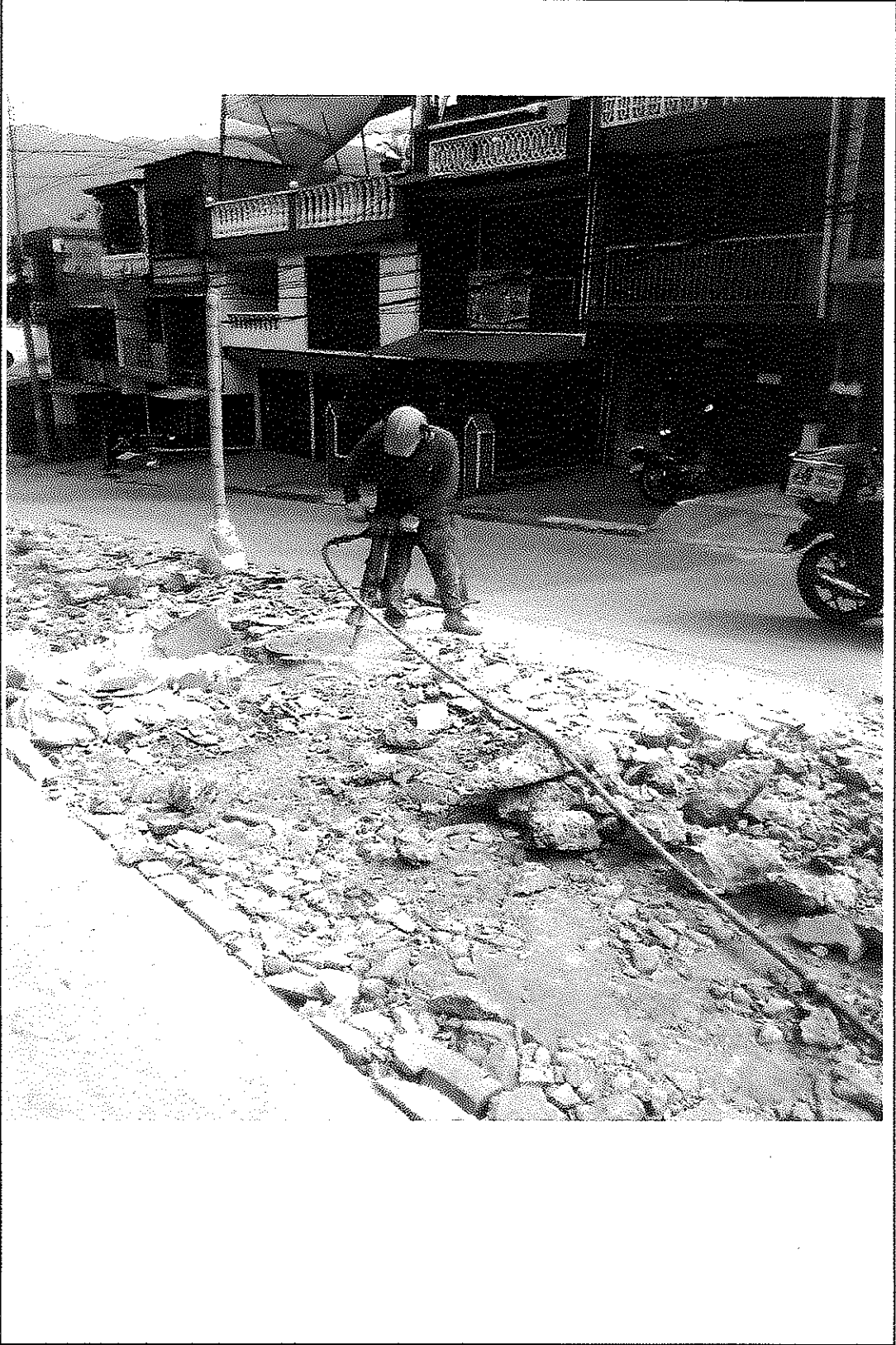
Rotura de pavimento rigido (CALLE 44 ENTRE 6TA Y 7MA)
