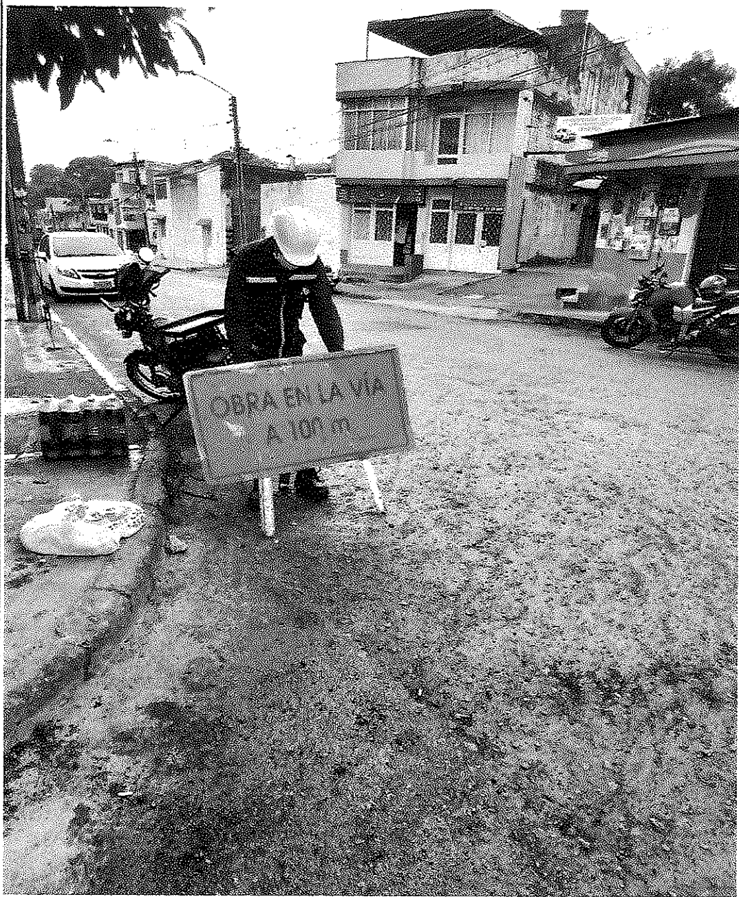
Señales provisional móvil para obra tipo trípode incluye tablero (LA FLORESTA CALLE 59 3-81)
