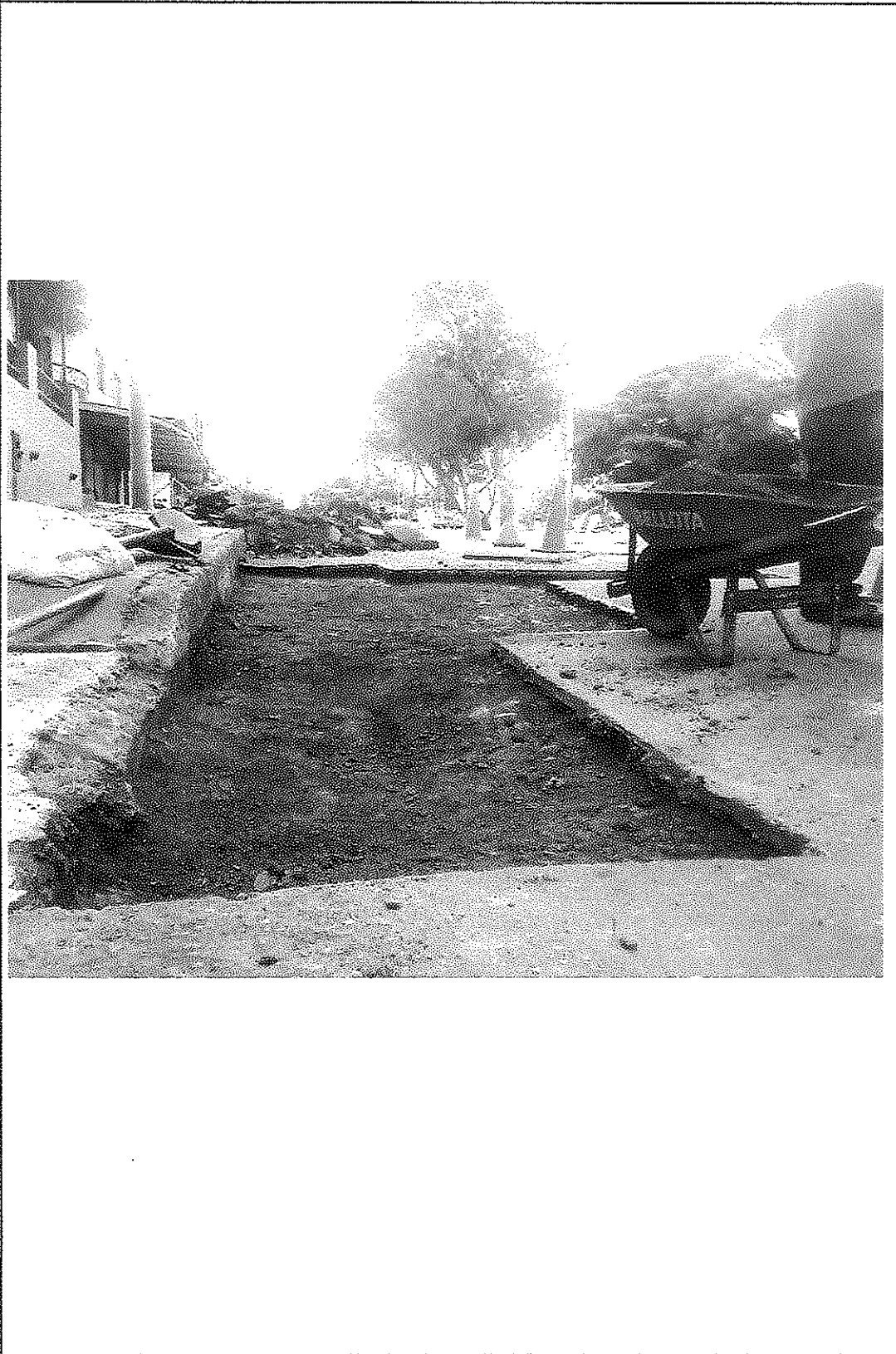
Demolicion de carpeta asfaltica (calle 44 con guabinal)
