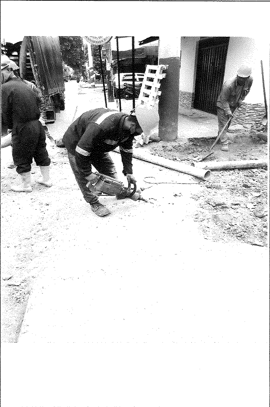
Rotura de pavimento rigido (EL SALADO CALLE 125)
