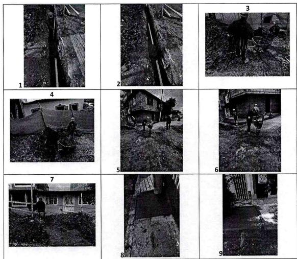
Se adjunta nueve (9) fotografías del proceso desarrollado y ejecutado en el acueducto VILLA DEL NORTE, en el cual evidenciamos: Operarios realizando el lleno con arena, lleno compacto con recebo, reposición de andenes, retiro y limpieza de escombro por medio de acarreo interno.
