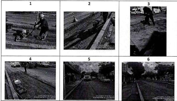
Se adjunta nueve (6) fotografías del proceso desarrollado y ejecutado en el alcantarillado ARKAMBUCO, en el cual evidenciamos: Operarios realizando compactación de recebo, lleno compacto con base
