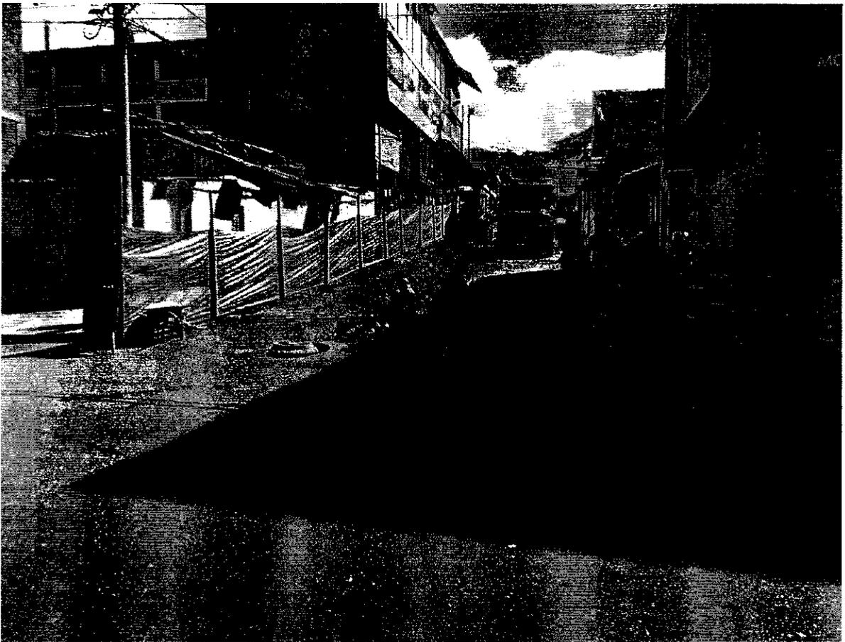
Ilustración 6 Excavación de zanja y retiro de material sobrante.
