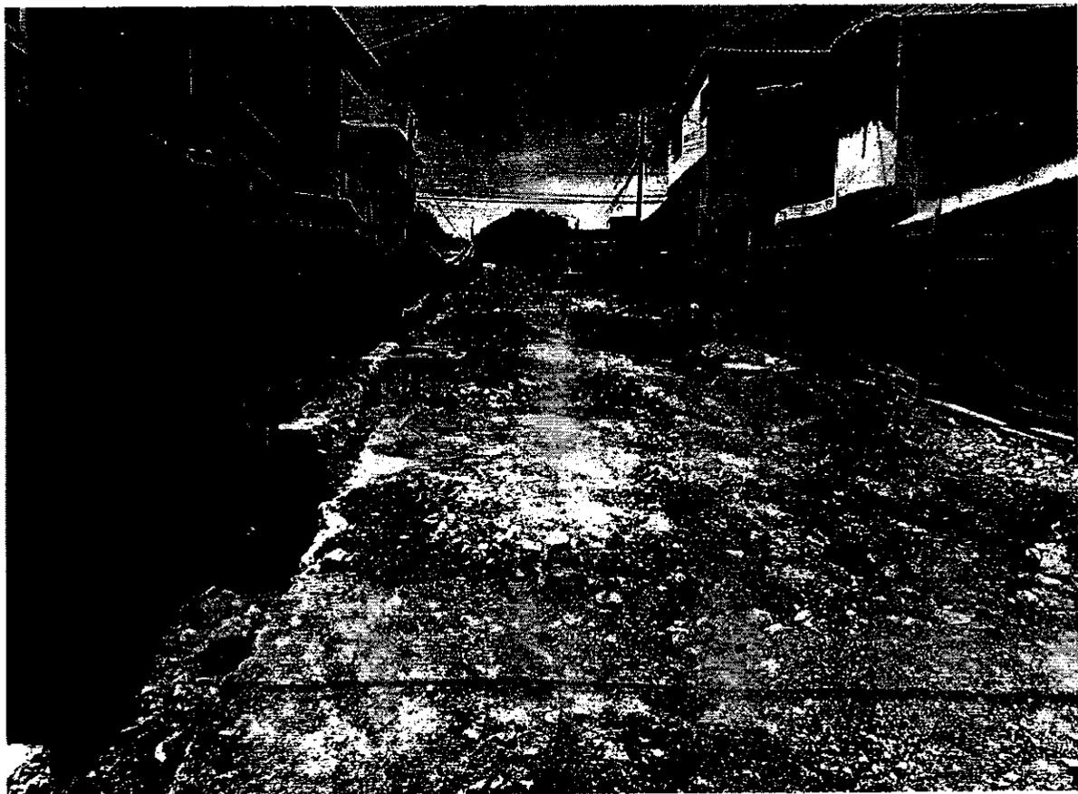
Ilustración 12 conformación con recebo compactado
