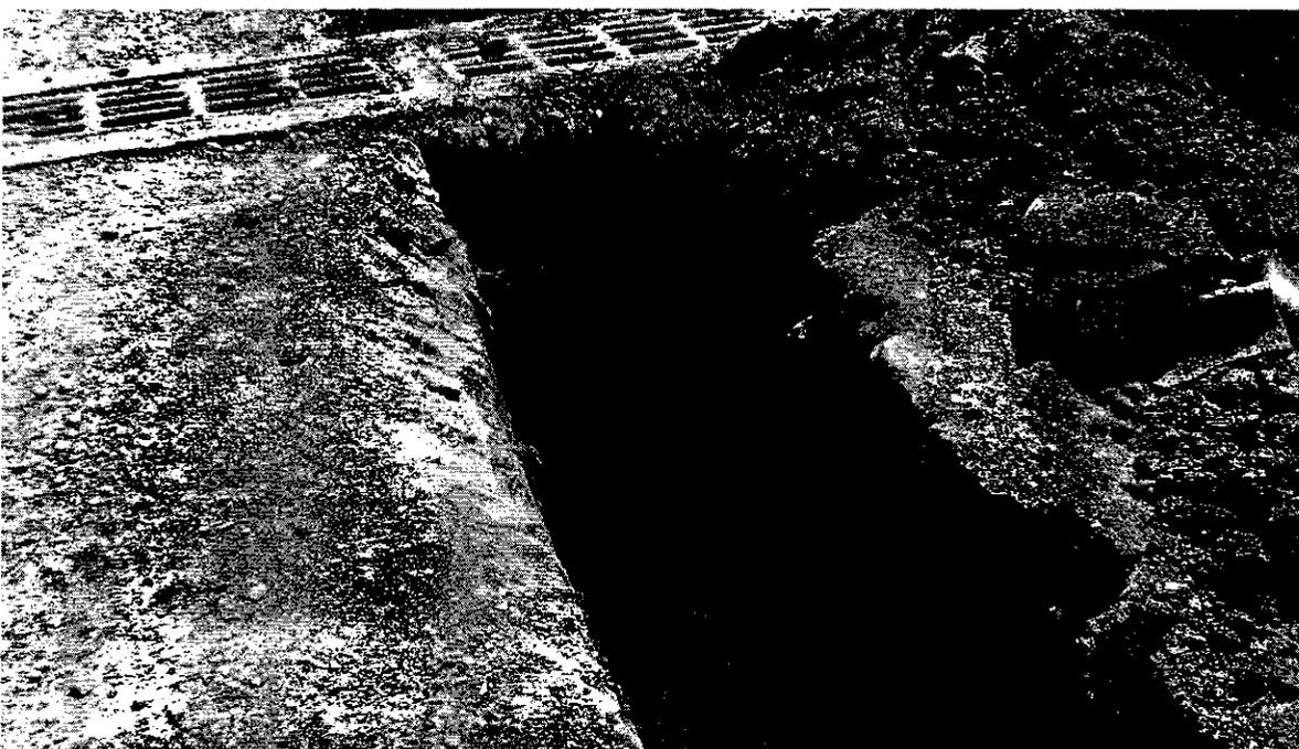
Ilustración 4 Excavación de zanja para instalación de tubería.
