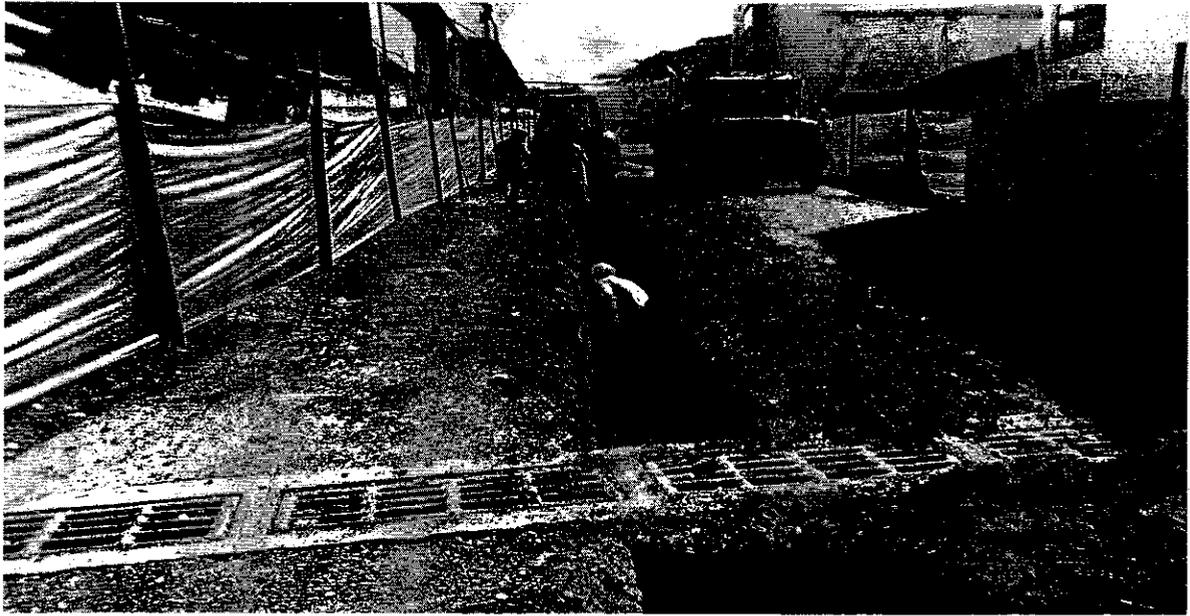
Ilustración 5 Excavación de zanja y retiro de material sobrante.
