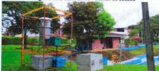
Fotografía 5.18 Estación 03 – Lechos de Secado
