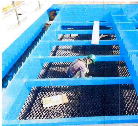
Montaje elementos 150 x10 para sostener canal central
