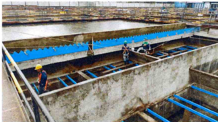
Aplicación de mortero para la superficie del vertedor lateral
