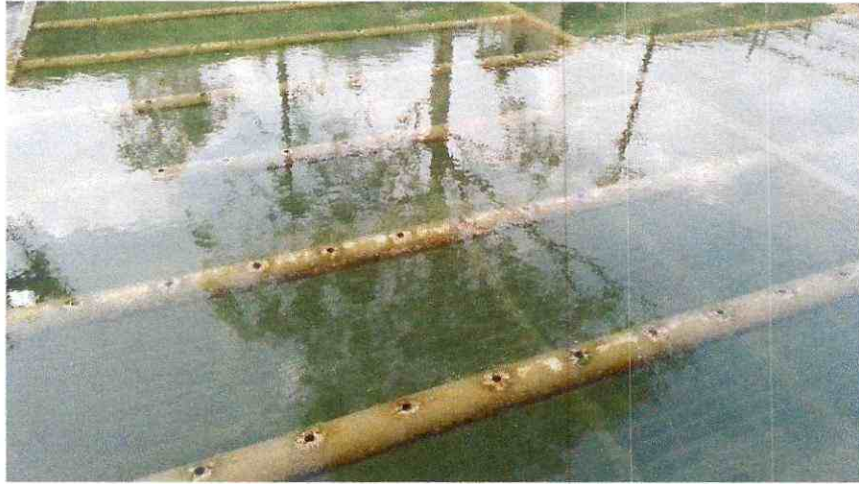
Demonte de tubería perforada
