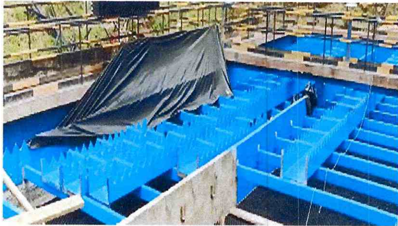
Montaje canal central de 0,60 m
