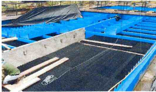
Montaje de modulos tipo colmena
