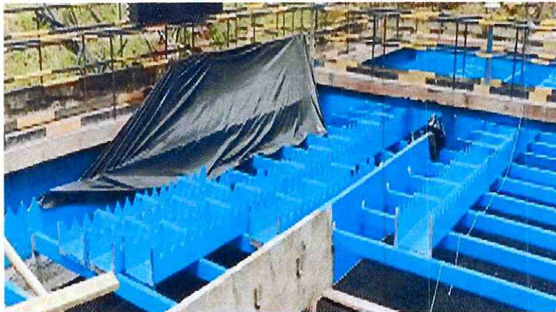
Pintura Epoxipolamida para muro y canales
