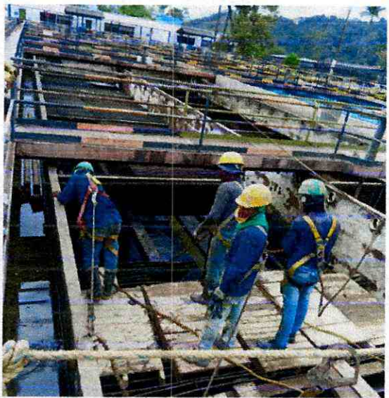
Img. 15 Extracción de láminas de asbestos
