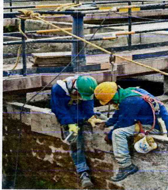
Img. 25 Resane de viga canal
