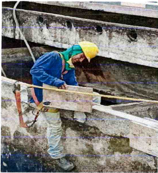
Img. 26 Resane de viga canal
