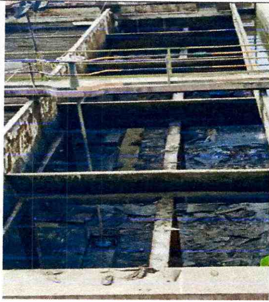
Img. 12 Retiro de escombros
