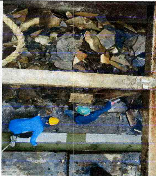
Img. 29 Recolección de escombros
