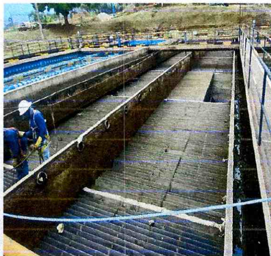
Img. 07 Extracción de láminas de asbestos
