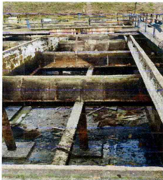
Img. 30 Recolección de escombros
