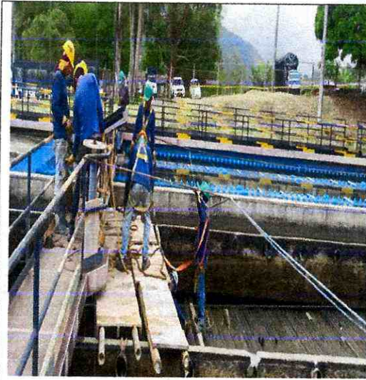
Img. 08 Extracción de láminas de asbestos
