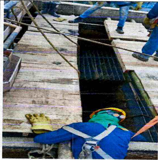
Img. 09 Extracción de láminas de asbestos
