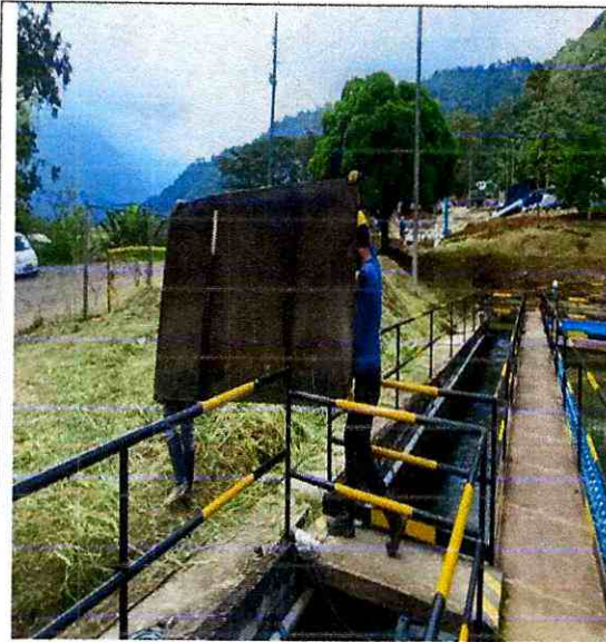
Img. 16 Extracción de láminas de asbestos
