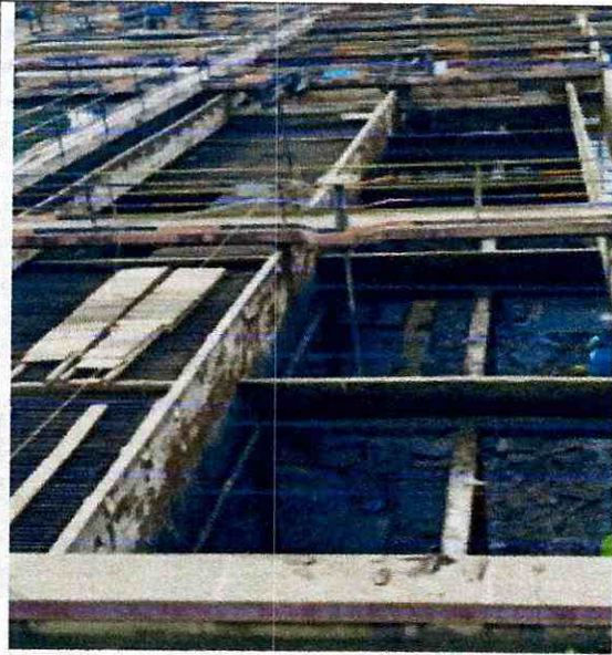
Img.13 Retiro de escombros
