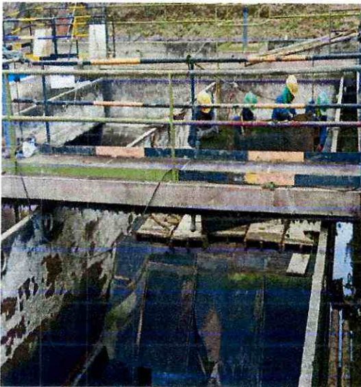
Img. 14 Extracción de láminas de asbestos
