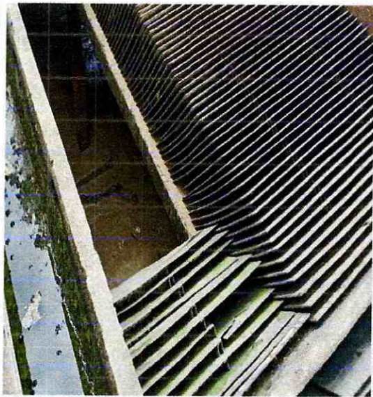
Img. 10 Extracción de láminas de asbestos
