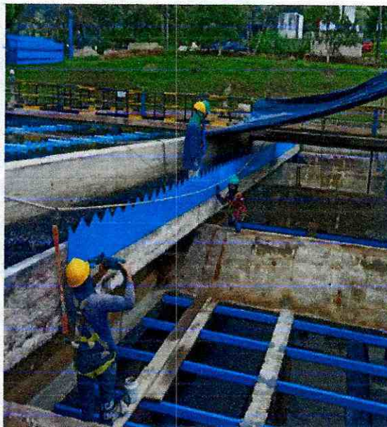
Img. 35 Instalación de vertedores laterales
