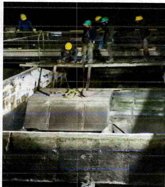
Img. 19 Extracción de láminas de asbestos
