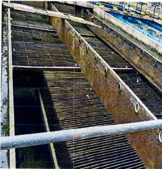
Img. 11 Extracción de láminas de asbestos
