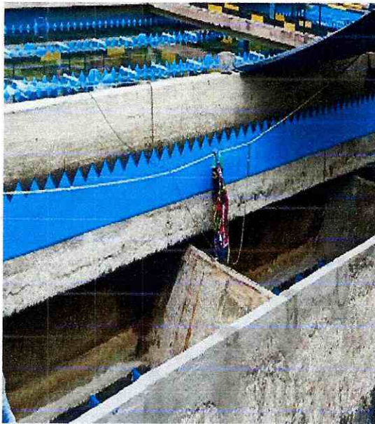
Img. 34 Instalación de vertedores laterales
