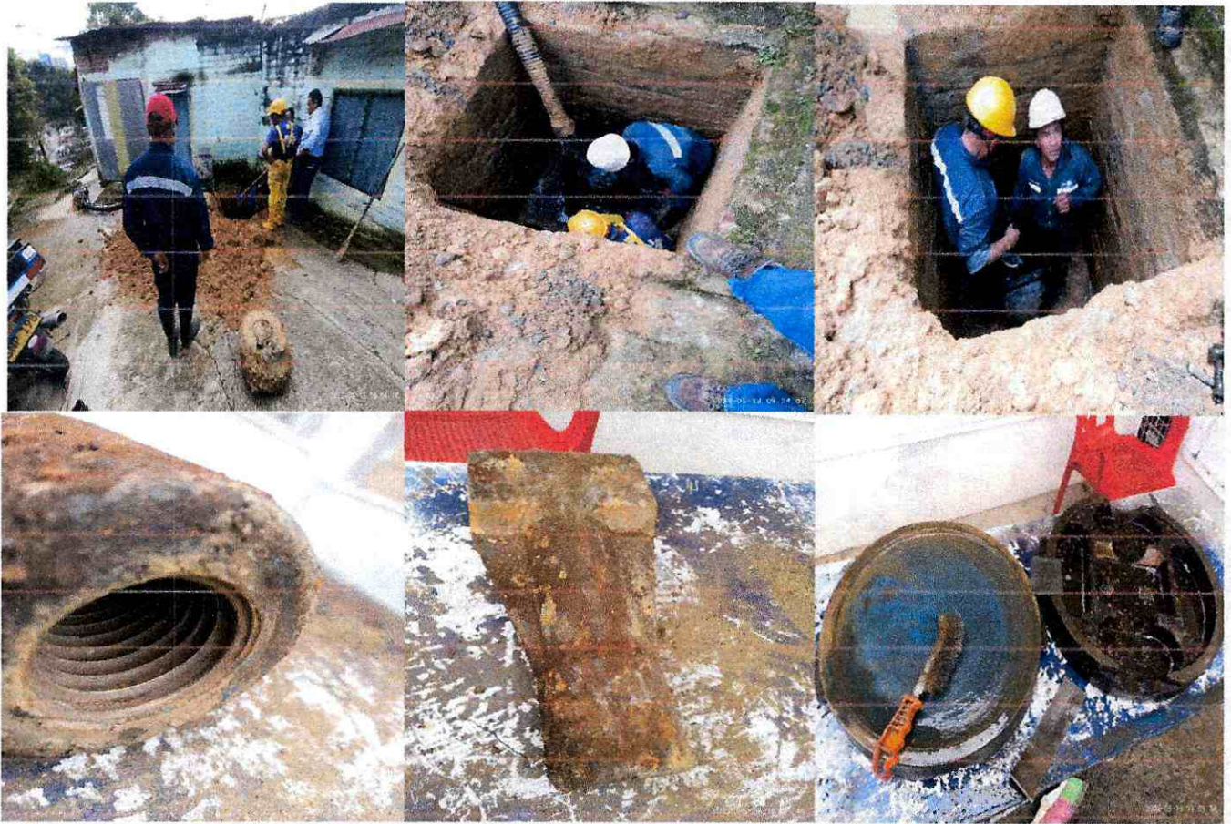
15,53 Mantenimiento a cheque línea de bombeo # 3 planta 1 Ibal
