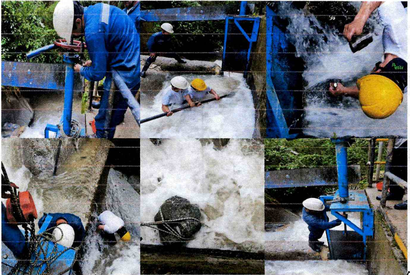
15,54 Retiro de roca obstrucción compuerta bocatoma chembe trabajos bajo agua
