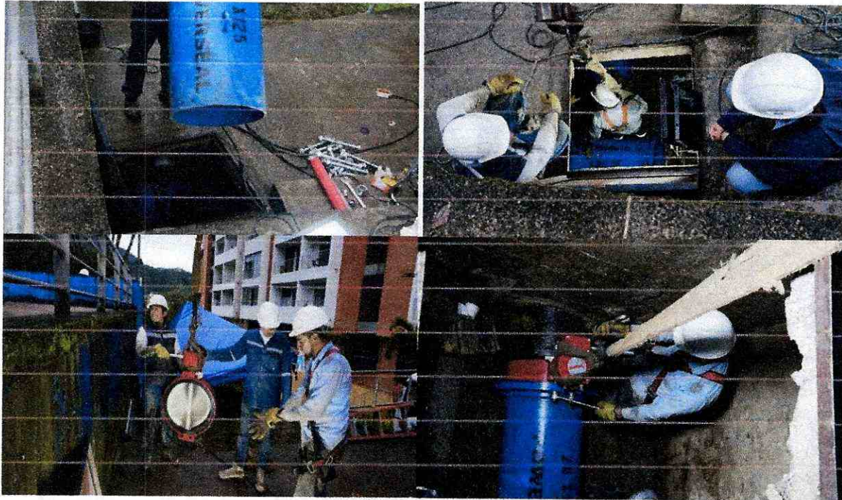
Válvula de 20 in y accesorios instalados.
