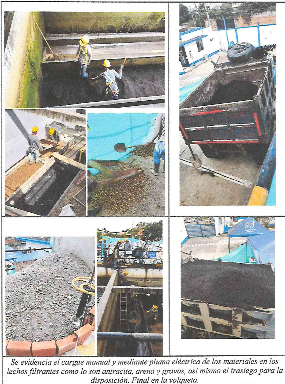
RETIRO DEL MATERIAL FILTRANTE DE LOS COMPARTIMIENTOS #6 Y #5
