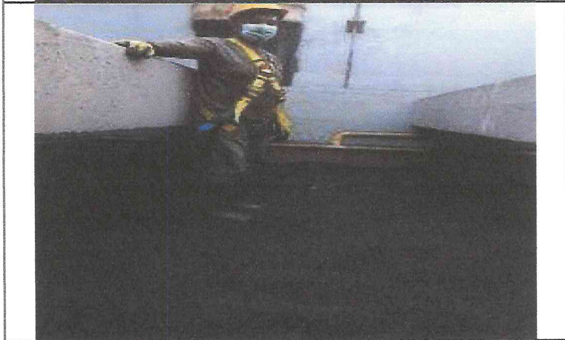
Se realiza la instalación de antracita en los filtros con su respectiva nivelada
